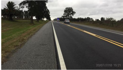
Ilustración 4 – Tramo de obra ejecutado
