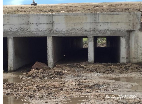
Ilustración 6 – Alcantarilla H en progresiva 227K500
