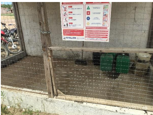
Ilustración 9 – Obrador: depósito de combustible con envallado perimetral.
