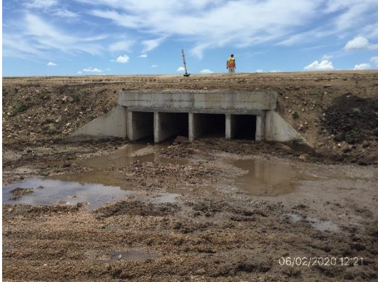
Ilustración 5 – Alcantarilla H en progresiva 227K500
