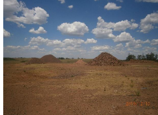
Ilustración 5 - Obrador desafectado. Acopio de materiales
