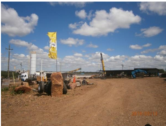
Ilustración 7 – Obrador principal Acopio de materiales varios
