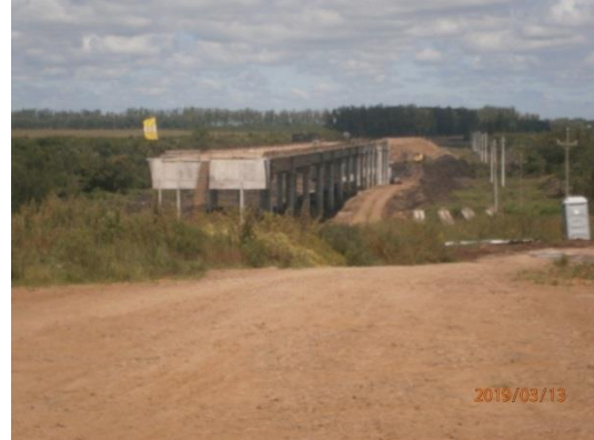
Ilustración 6 - Puente sobre el A° Cuaró desde el Obrador Principal
