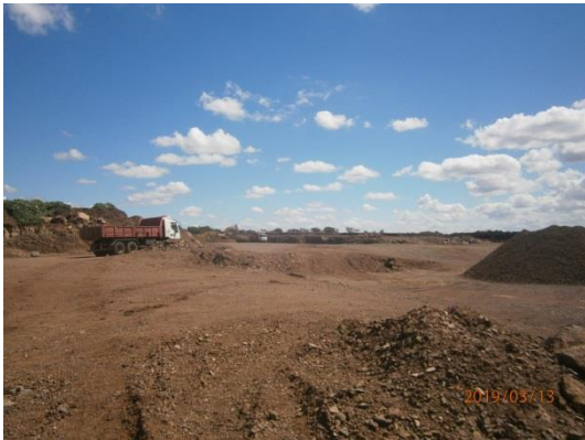
Ilustración 13 – Cantera CUJO-INCOCI para movimiento de suelos
