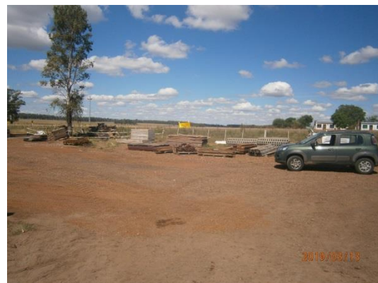
Ilustración 16 – Obrador de CUJÓ-INCOCI propiedad de vialidad
