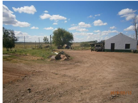
Ilustración 14 – Obrador de CUJÓ-INCOCI propiedad de vialidad
