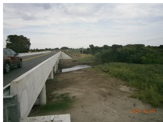
Ilustración 9 – Vista lateral del puente.
