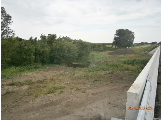
Ilustración 10 – Sector debajo del puente limpio
