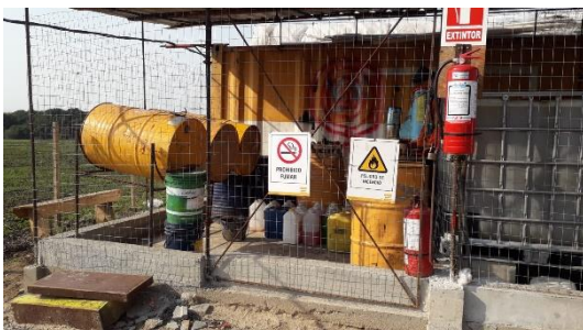
Ilustración 16 – Registro Fotográfico enviada por representante de la empresa SACEEM de acopio en Obrador de Mat. Cat. I Dec. 182/13.
