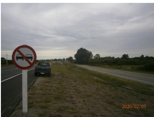
Ilustración 8 – Accesos al puente.
