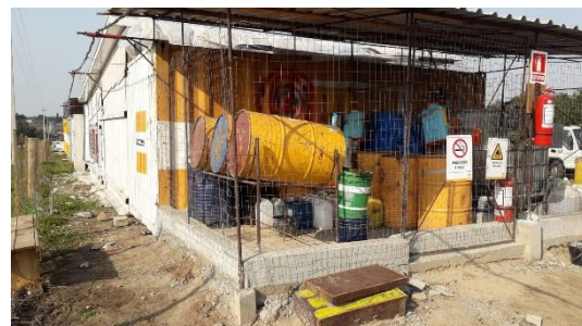
Ilustración 17 – Registro Fotográfico enviada por representante de la empresa SACEEM de acopio en Obrador de Mat. Cat. I Dec. 182/13.
