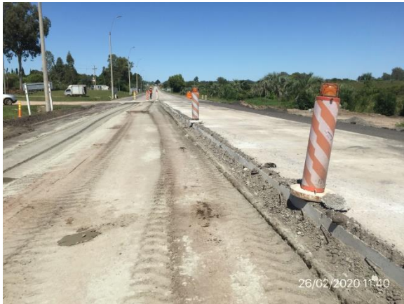
Ilustración 18 – Tramo de obras en Ruta 5 en planta urbana de Durazno
