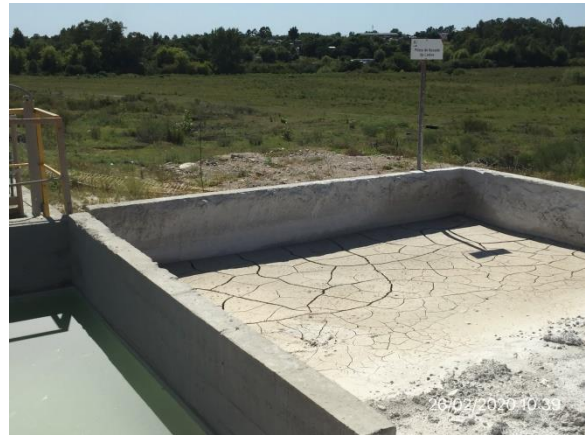
Ilustración 11 – P03, Lodos de lavado que ingresan nuevamente al proceso
