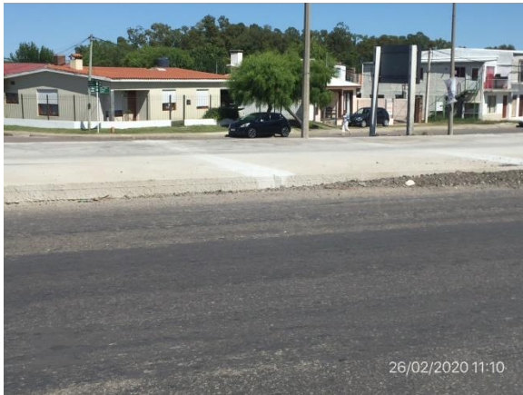
Ilustración 16 – Tramo de obras en Ruta 5 en planta urbana de Durazno
