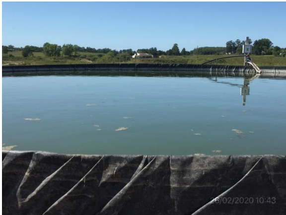
Ilustración 12 – P03, Planta de hormigón, tajamar de acumulación de agua subterránea desde pozo
