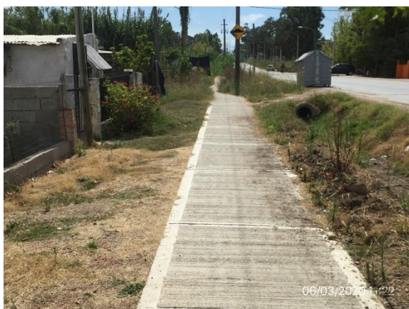
Ilustración 6 – Tramo de obra terminado, con tareas de recuperación realizadas.
