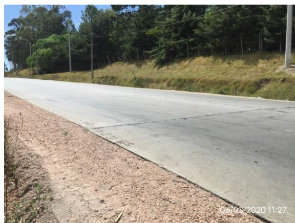
Ilustración 7 – Tramo de obra terminado, con tareas de recuperación realizadas
