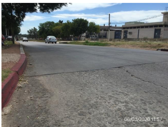
Ilustración 8 – P01, Inicio de obra, Intersección de Av. de las Instrucciones con Br. Aparicio Saravia.
