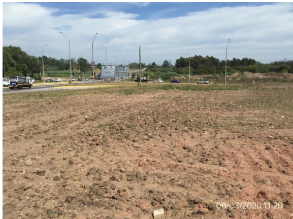
Ilustración 4 – P03, Obrador desafectado y recuperado, Av. de las Instrucciones y Ruta 102
