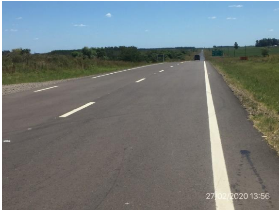
Ilustración 4 – Tramo de obra terminado. Tareas de PRA ejecutadas correctamente, empastado de la faja de ruta adecuado.
