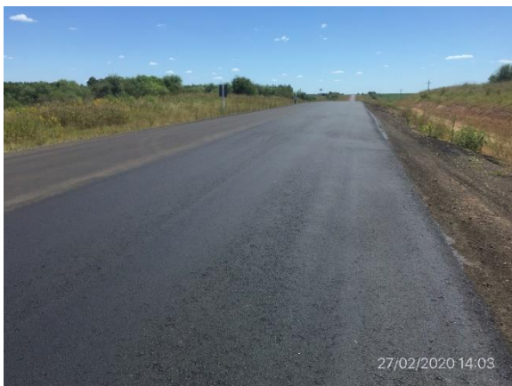
Ilustración 6 – Tramo de obra en fase de terminaciones, esperando subcontrato de señalización.
