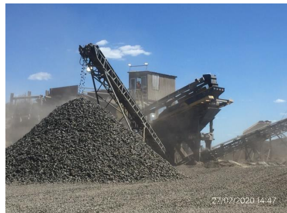
Ilustración 7 – Obrador. Planta de trituración operativa.
