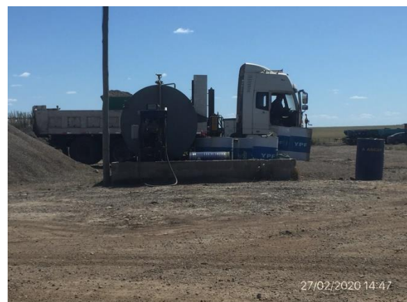
Ilustración 9 – Obrador. Depósito de combustible con envallado perimetral.
