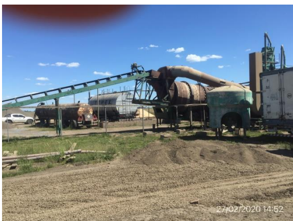
Ilustración 8 – Obrador. Planta de asfalto
