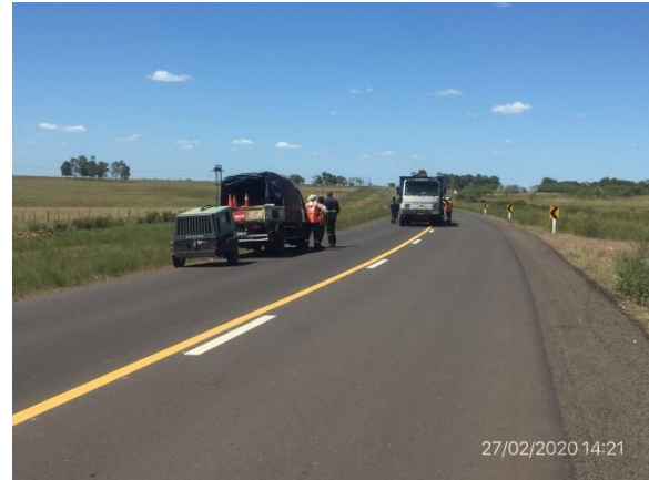
Ilustración 5 – Tramo de obra en fase de terminaciones.
