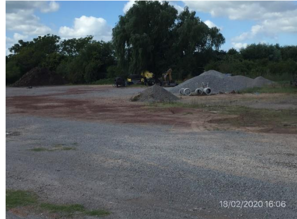
Ilustración 5 – Obrador dismantado y restituído al propietario.
