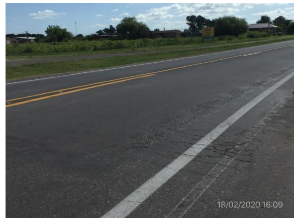
Ilustración 7 – Obra ejecutada, sin vestigios de escombros o desechos
