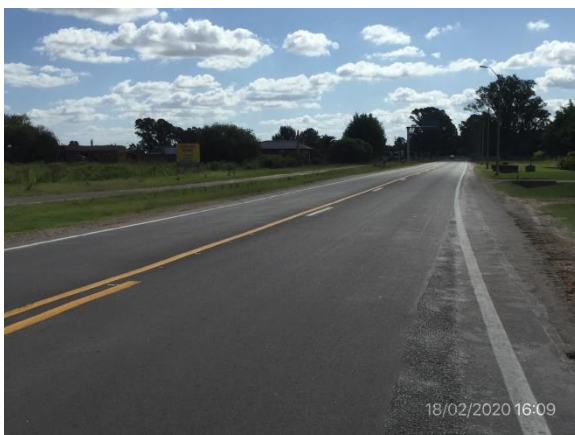
Ilustración 8 – Obra ejecutada, cubierta vegetal en faja correcta.
