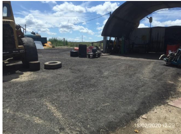
Ilustración 7 – Obrador. Nuevo suelo compactado en accesos a zona de taller.
