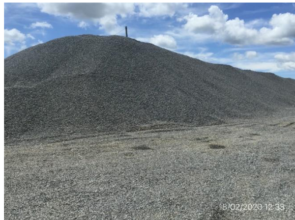
Ilustración 9 – Obrador. Zona de acopio de materiales.
