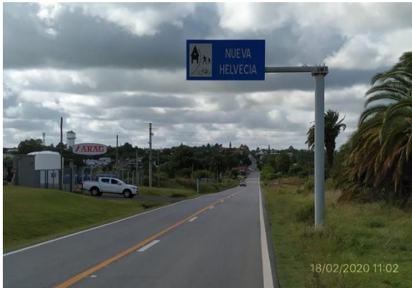
Ilustración 16 - Tramo de obras terminado
