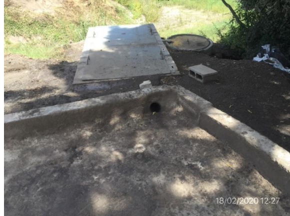
Ilustración 5 - Obrador. Trampa para aguas de lavado.
