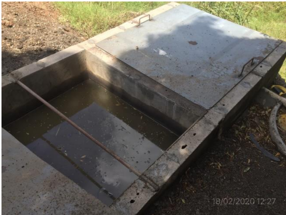
Ilustración 6 - Obrador. Trampa para aguas de lavado.
