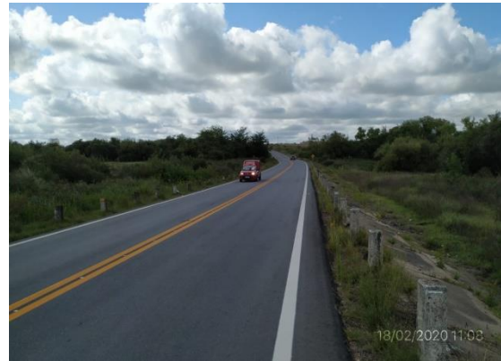
Ilustración 17 - Tramo de obras terminado
