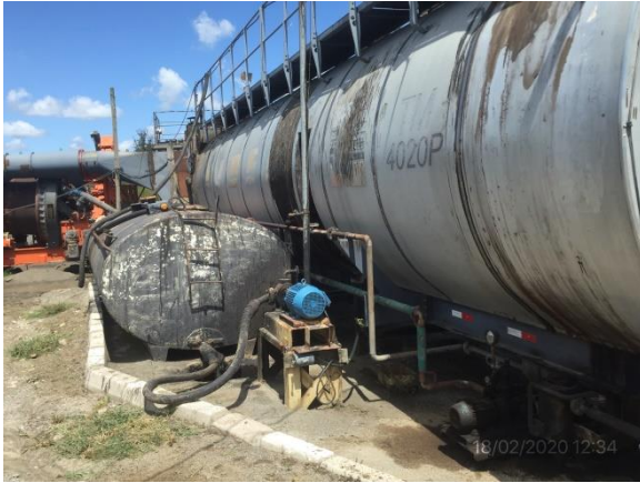
Ilustración 10 – Obrador. Planta de asfalto con envallado perimetral
