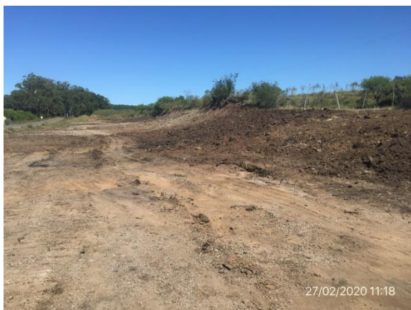
Ilustración 10 – Desmonte de terraplén en faja de Ruta 31 para uso como material de base
