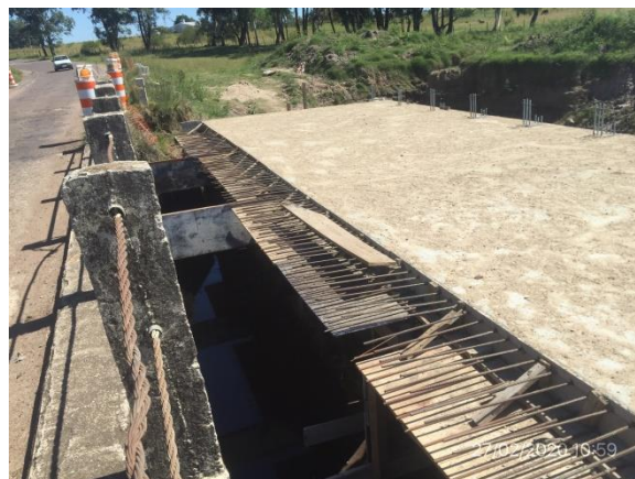
Ilustración 5 – Alcantarilla en obra, P04.
