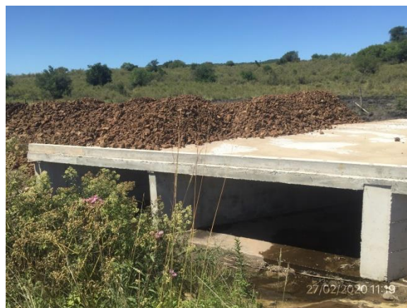
Ilustración 11 – Alcantarilla en obra, P02
