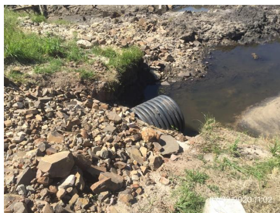
Ilustración 7 – Alcantarilla en obra, P03.
