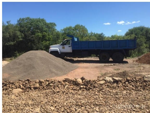
Ilustración 13 – Alcantarilla en obra y Obrador, P01. Acopio de áridos
