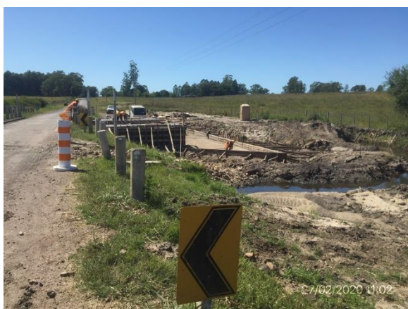
Ilustración 6 – Alcantarilla en obra, P03.
