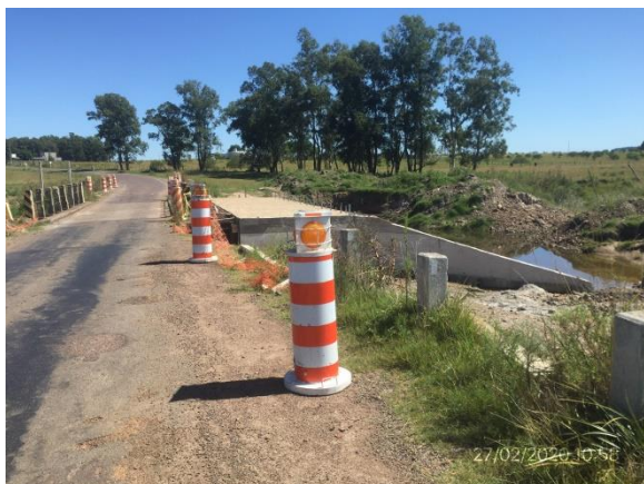
Ilustración 4 – Alcantarilla en obra, P04.
