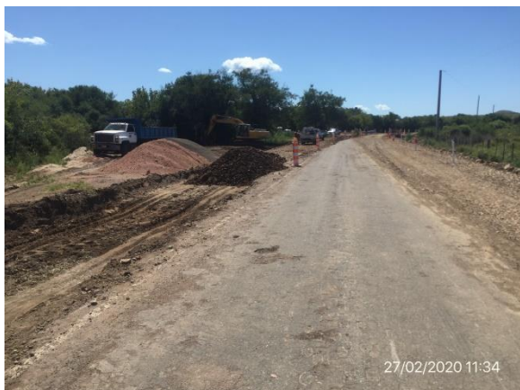
Ilustración 12 – Alcantarilla en obra y Obrador, P01
