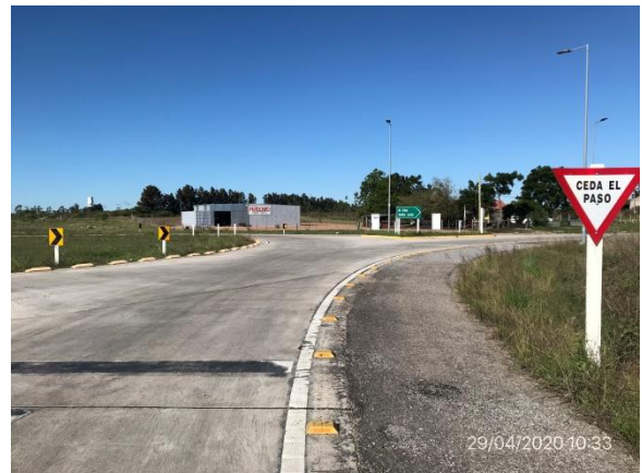
Ilustración 7 – P03, nueva rotonda en empalme Ruta 81 y Ruta 5 vieja.
