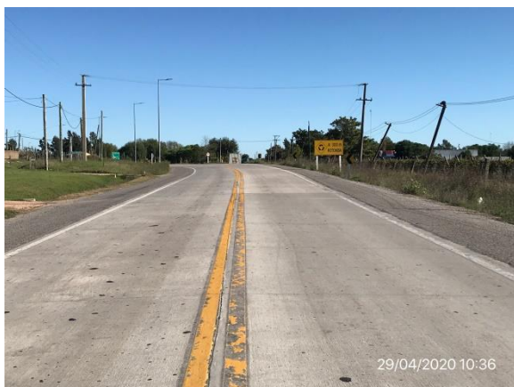
Ilustración 8 – Ruta 11, tramo de obra terminado
