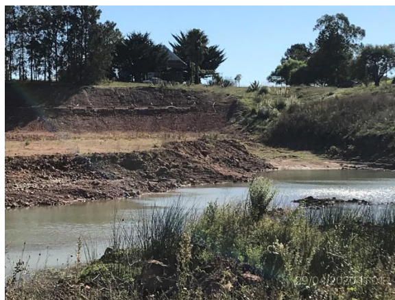
Ilustración 11 – P06, Cantera de piedra. Ruta 81 progresiva 16K600 a (-), padrón 17323 2ª SC Canelones. Tareas de suavizado de taludes realizadas de forma apegada al PRA.
