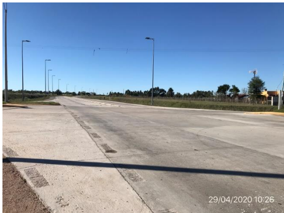
Ilustración 6 – P01, Inicio de tramo. Empalme Rutas 81 y Ruta 62
