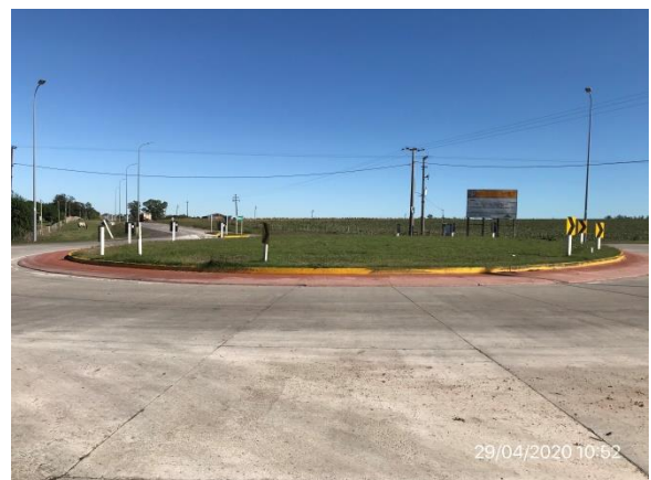
Ilustración 9 – P02 fin de tramo, acondicionamiento de rotonda en empalme Ruta 81 y Ruta 5.
