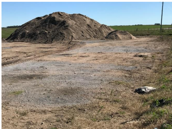
Ilustración 8 – P03, obrador desmantelado. Acopio de áridos cedido a solicitud de propietario del predio
