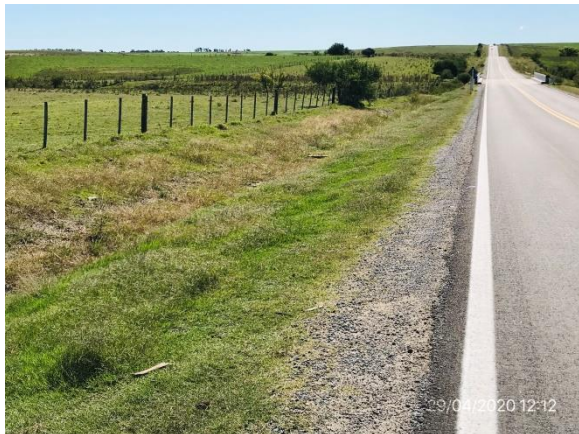
Ilustración 6 – Tareas de recuperación realizadas en faja de ruta, Ramal Ruta 5. Empastado de faja adecuado
