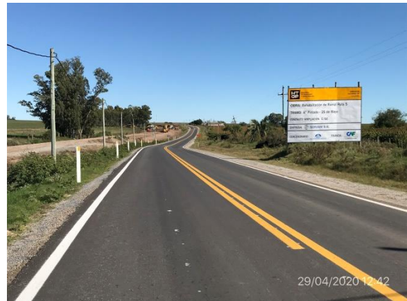
Ilustración 7 – P02, cartel de obra en fin de tramo de obras, Ramal Ruta 5.
