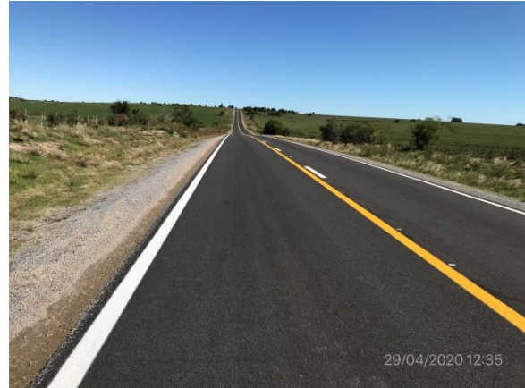
Ilustración 5 – Obras viales terminadas en Ramal Ruta 5.
