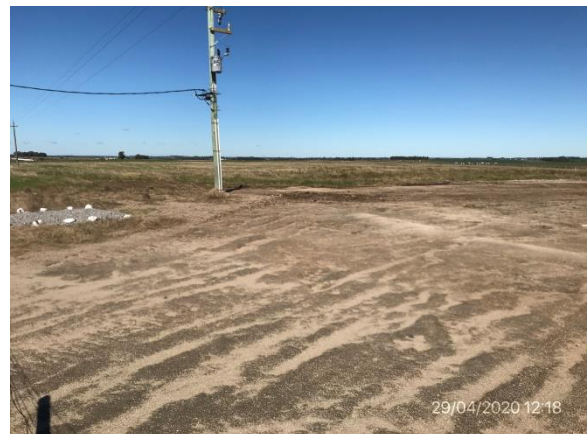
Ilustración 9 – P03, obrador desmantelado. Explanada compactada sin remover a solicitud de propietario del predio
