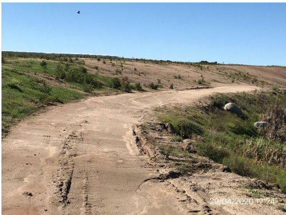
Ilustración 12 – P04, Cantera desafectada Caminos de acceso conservados a solicitud del propietario del predio
