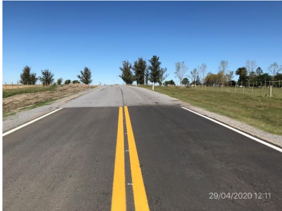
Ilustración 4 – P01, Inicio de tramo de obras en Ramal Ruta 5.
