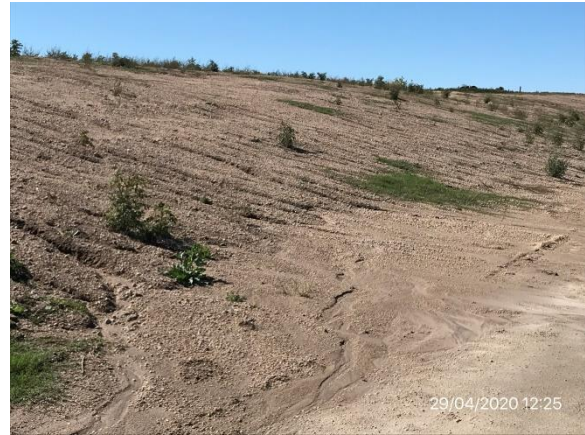
Ilustración 11 – P04, Cantera desafectada. Taludes suavizados a solicitud del propietario del predio.
