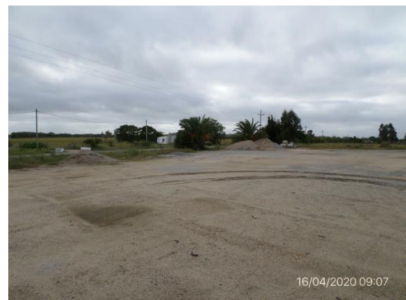
Ilustración 9 – P03, obrador desmontado. Padrón Rural 623, 6ª Sección Catastral, San José
