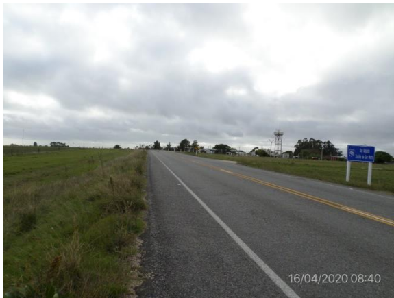
Ilustración 6 – Tramo de obra terminado, con tareas de recuperación ambiental realizadas.
