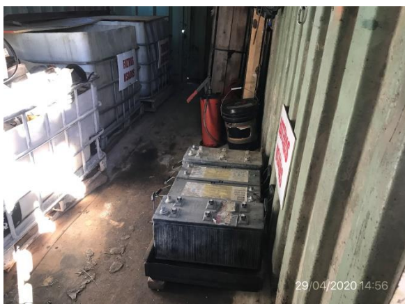
Ilustración 14 – P03, obrador. Depósito de baterías en bandejas metálicas dentro de depósito contenerizado
