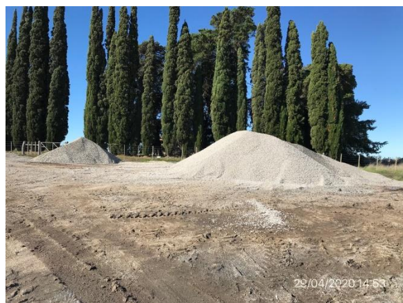
Ilustración 9 – P03, obrador. Acopio de áridos
