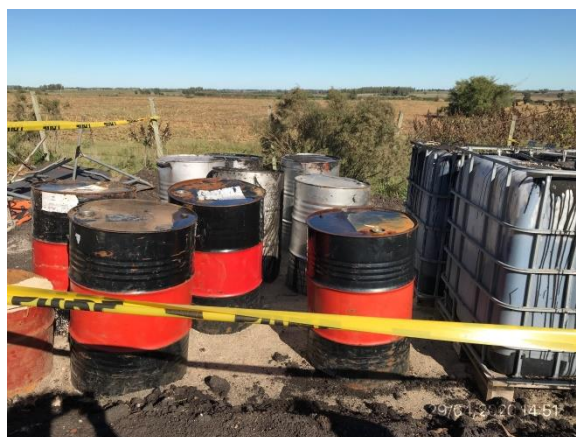
Ilustración 13 – P03, obrador. Tanques móviles de emulsión asfáltica con envallado perimetral y superficie inferior impermeabilizada
