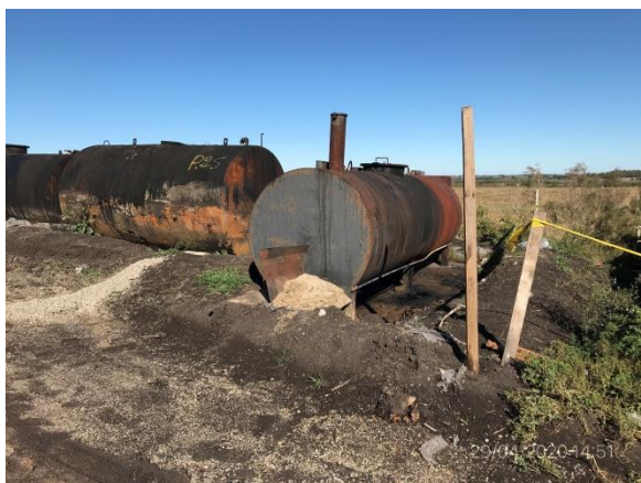
Ilustración 10 – P03, obrador. Depósitos fijos de emulsión asfáltica con envallado perimetral y superficie inferior impermeabilizada
