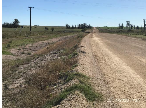
Ilustración 5 – Tramo en construcción en Ruta 65
