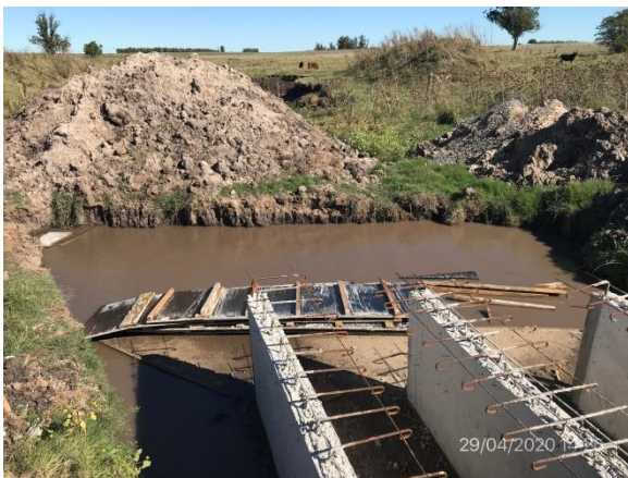
Ilustración 6 – Frente de obras, reconstrucción de alcantarilla en C da Villegas, Ruta 65 prog. 75K900
