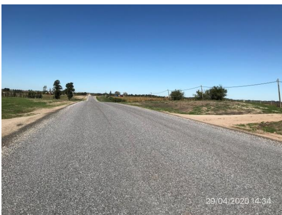
Ilustración 8 – Frente de obras, Ruta 65. Ensanchado de base y primer riego terminados
