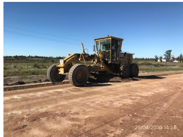
Ilustración 7 – Frente de obras, Ruta 65. Ensanchado de base
