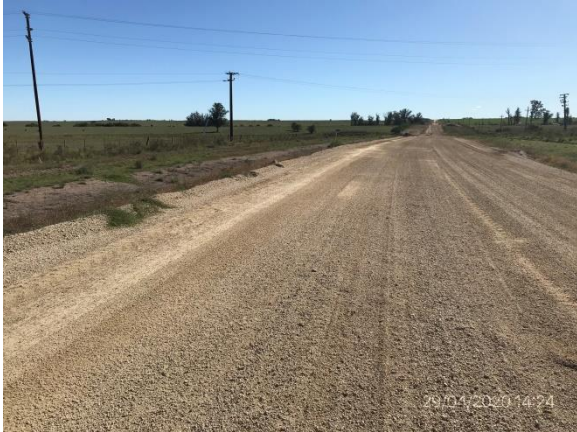
Ilustración 4 – P01, Inicio de tramo de obras en Ruta 65
