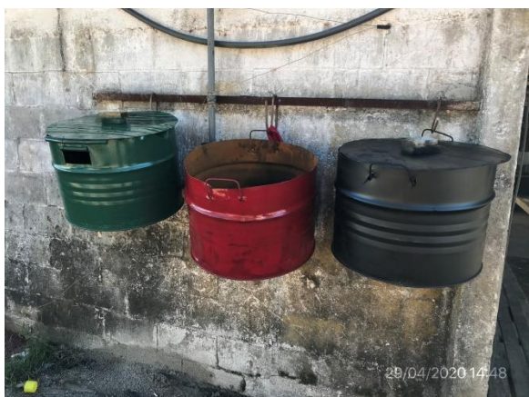
Ilustración 12 – P03, obrador. Residuos segregados según PGA por corriente de generación
