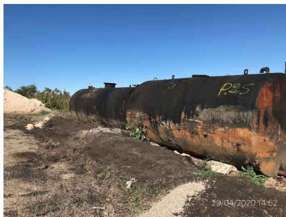
Ilustración 11 – P03, obrador. Depósitos de emulsión asfáltica con envallado perimetral y superficie inferior impermeabilizada
