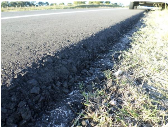
Ilustración 20 – Obras de recapado terminadas en Ruta 1
