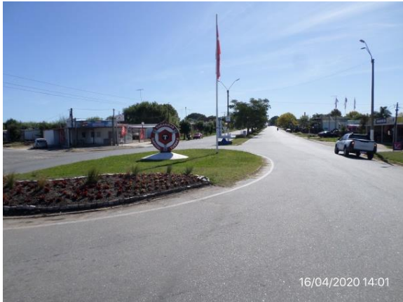
Ilustración 18 – P01b. Inicio de Tramo de obras en Ruta 54 terminado – Tarariras
