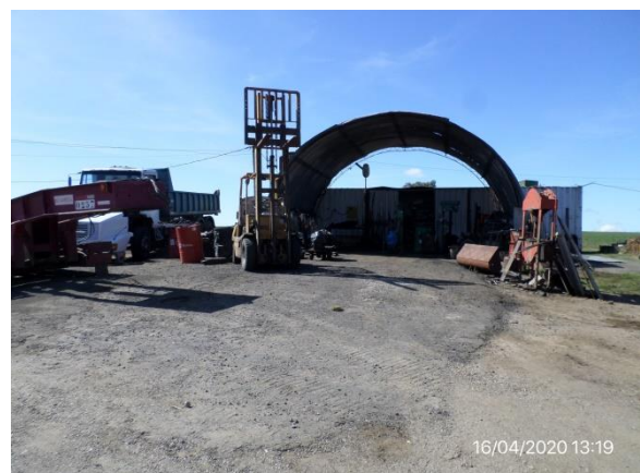
Ilustración 7 – Obrador. Nuevo suelo compactado con recubrimiento bituminoso en zona de taller.
