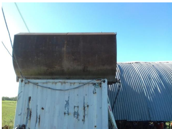
Ilustración 12 – Obrador. Tanque elevado para acopio de agua no potable alimentado desde camiones cisterna
