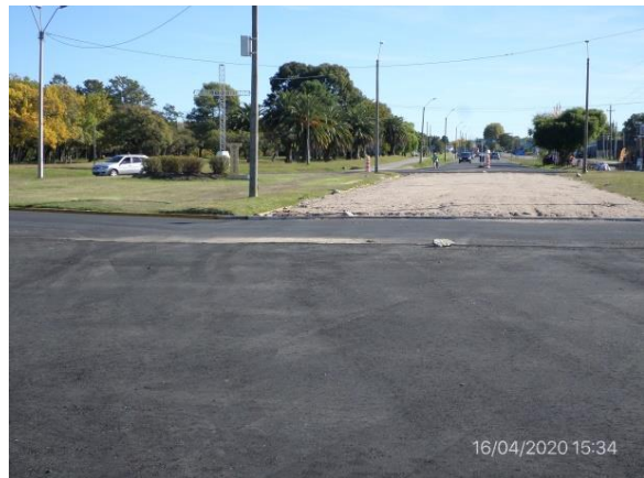
Ilustración 21 – P03. Rotonda en empalme de Ruta 1 con Av. Jose Batlle y Ordoñez. – Colonia del sacramento
