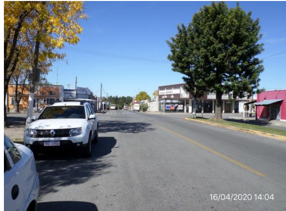
Ilustración 19 – P02b. Fin de Tramo de obras en Ruta 54 terminado - Tarariras
