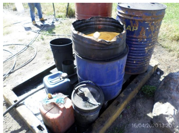
Ilustración 9 – Obrador. lubricantes usados acopiados en bandeja metálica
