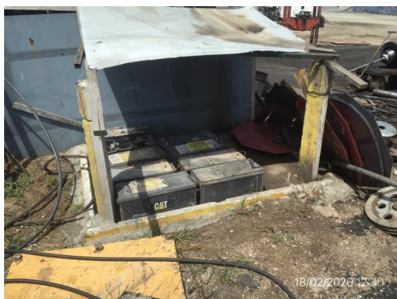
Ilustración 8 – Obrador. Zona de acopio de baterías con techo y envallado perimetral.
