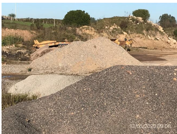
Ilustración 8 – P04, obrador desmantelado. Acopio de áridos cedido a solicitud de propietario del predio
