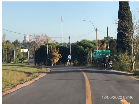
Ilustración 7 – Obras viales terminadas en Ruta 81, planta urbana de Migues
