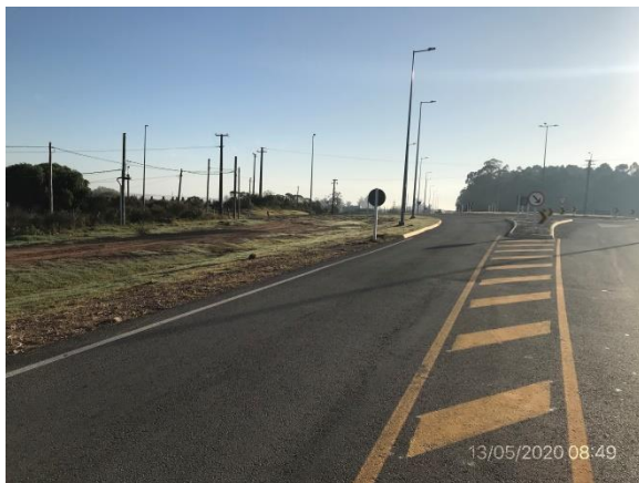
Ilustración 6 – Obras viales terminadas en Ruta 80, planta urbana de Migues
