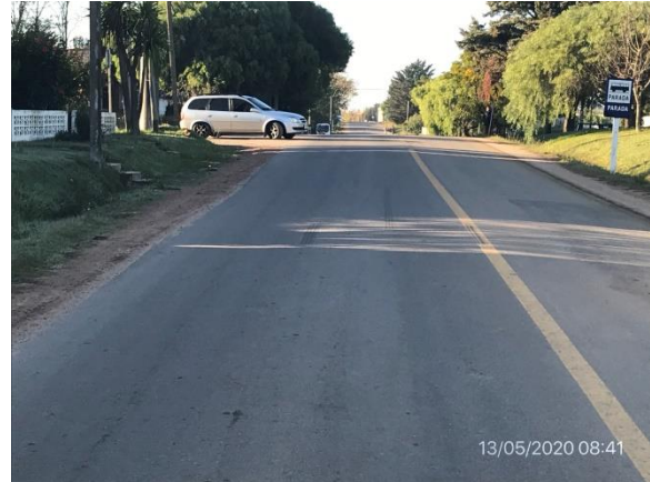
Ilustración 5 – Obras viales terminadas en Ruta 80, planta urbana de Migues
