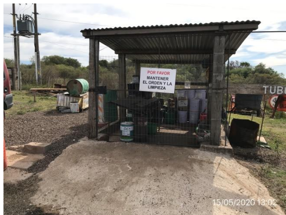
Ilustración 14 – P07. Obrador. Depósito de lubricantes sobre pavimento impermeable y con envallado perimetral
