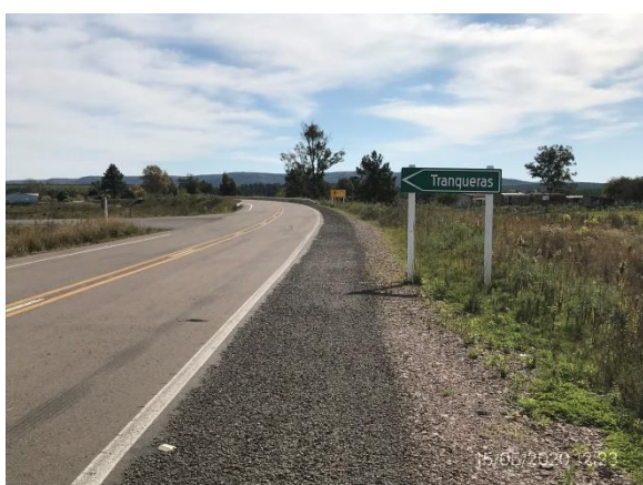
Ilustración 8 – P05, nueva rotonda de acceso a la localidad de Tranqueras, Ruta 30 progresiva 253K700
