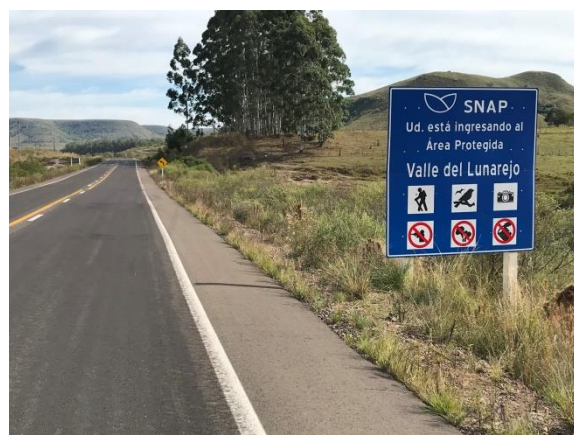
Ilustración 7 – Tramo de obra terminado en Ruta 30, zona protegida SNAP Valle del Lunarejo, Bajada de Pena
