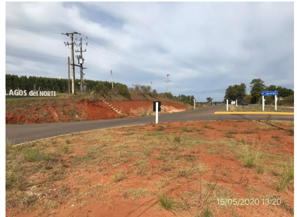
Ilustración 11 – P03. Ruta 27 progresiva 7K500, nueva rotonda de acceso a Lagos del Norte.
