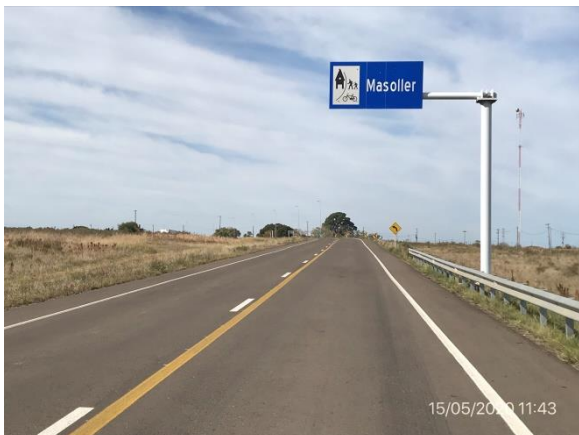
Ilustración 4 – P06 Fin de tramo de Ruta 30, progresiva 221K800, localidad de Masoller.
