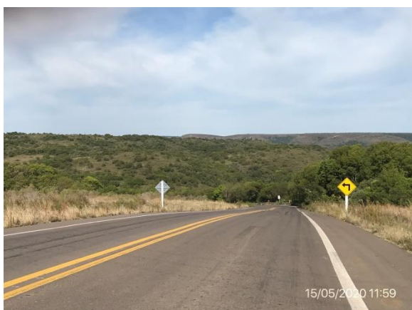
Ilustración 6 – Tramo de obra terminado en Ruta 30, zona protegida SNAP Valle del Lunarejo, Bajada de Pena
