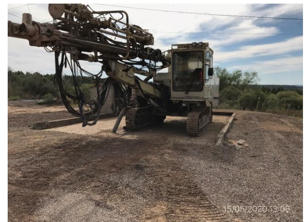
Ilustración 15 – P07. Obrador. Sector de lavado de maquinaria con pavimento impermeable y cordoneta perimetral
