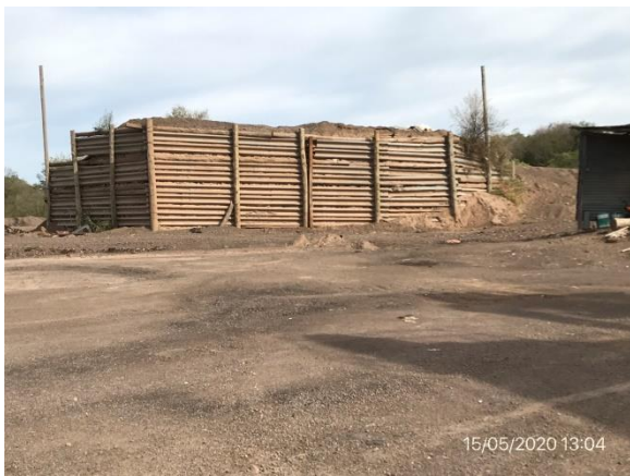
Ilustración 12 – P07. Obrador. Sector de trituración y abastecimiento de planta asfáltica desmontado
