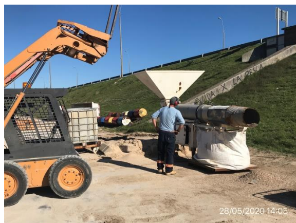
Ilustración 7 – P03, Obrador. Acopio de arena zarandeada y secada para arenado
