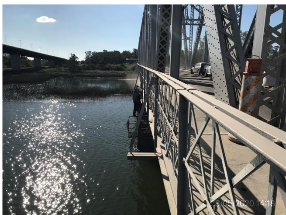
Ilustración 6 – Obras de arenado y pintura en puente metálico sobre Punte Santa Lucía
