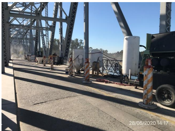
Ilustración 4 – Obras de arenado y pintura en puente metálico sobre Punte Santa Lucía
