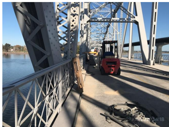
Ilustración 5 – Obras de arenado y pintura en puente metálico sobre Punte Santa Lucía
