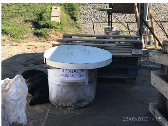
Ilustración 8 – P03, Obrador. Acopio de residuos asimilables a domésticos
