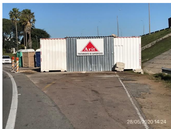
Ilustración 9 – P03, Obrador. Contenedor de pinturas de subcontratista Arit SRL que brinda el servicio de arenado y pintado
