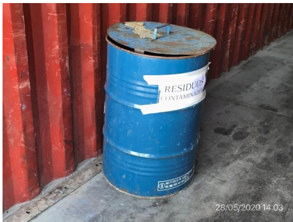
Ilustración 12 – P03, Obrador. Acopio de residuos Cat. 1 según Dec. 182/013 en contenedor cerrado
