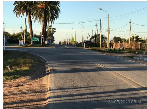
Ilustración 7 – P01, inicio de tramo, Ruta 34 progresiva 43K200 rotonda proyectada sin ejecutar en intersección con Ruta 87,
