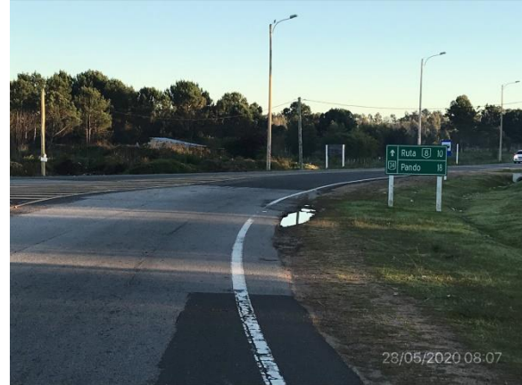
Ilustración 5 – Obras de bacheo de Ruta 34 terminadas
