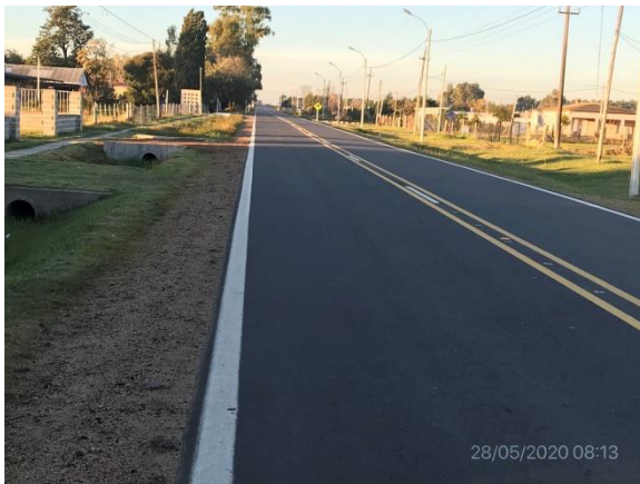
Ilustración 6 – Obras de recapado de Ruta 34 terminadas, con recuperación ambiental de la faja culminada
