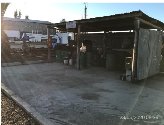
Ilustración 14 – P03. Obrador, acopio envallado de lubricantes usados
