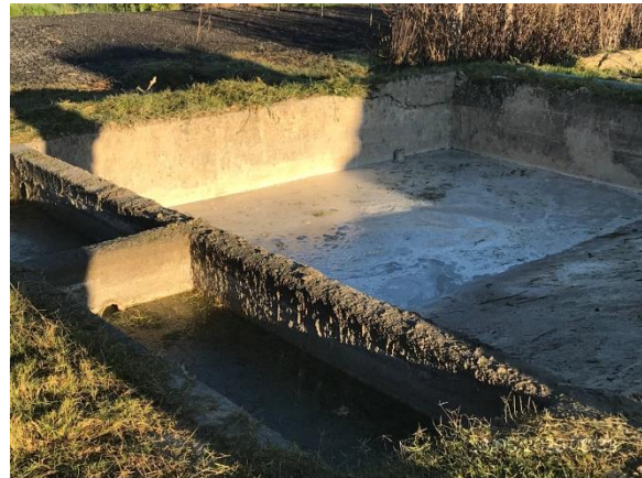
Ilustración 13 – P03. Obrador Sector para lavado de camiones mixer
