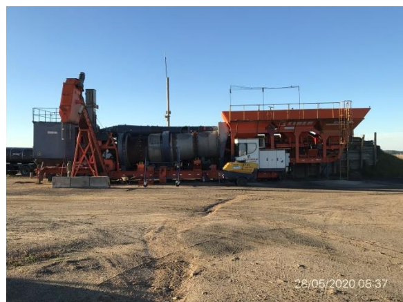
Ilustración 15 – P03. Obrador, planta asfáltica fuera de operación, en tareas de mantenimiento.
