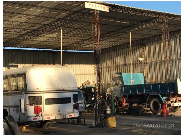
Ilustración 11 – P03. Taller techado con pavimento en hormigón.
