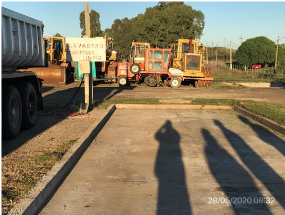
Ilustración 12 – P03. Obrador. Sector para lavado de camiones con pendientes hacia sistema de decantación.
