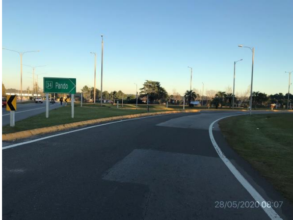
Ilustración 4 – P02 – fin de tramo, Ruta 37 progresiva 49k000, intersección con Ruta Interbalnearia
