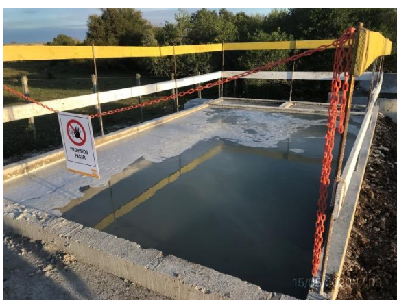
Ilustración 8 – P02. Obrador. Pileta impermeable para lavado de camiones mixer.
