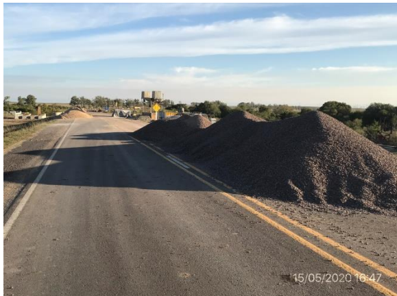
Ilustración 4 – P01, acceso de Ruta 5 a puente sobre A° Malo cerrado al tránsito
