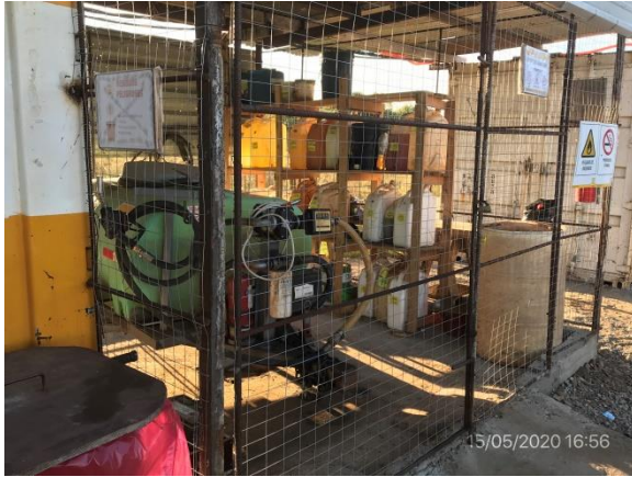
Ilustración 10 – P02. Obrador, acopio envallado de lubricantes nuevos
