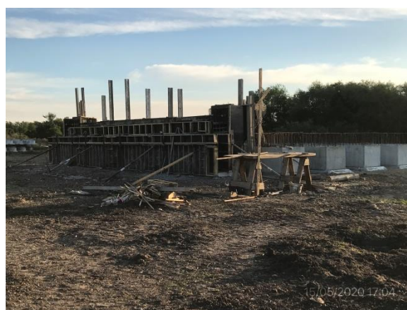
Ilustración 9 – P02. Obrador, acopio de prefabricados de hormigón en sitio.
