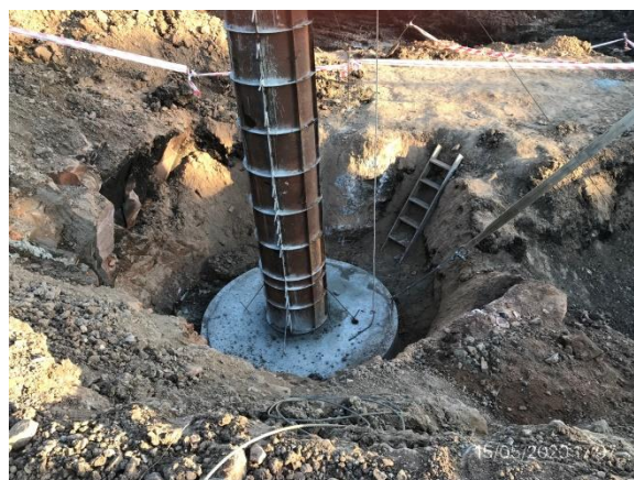
Ilustración 7 – P01, nuevas cimentaciones en construcción para nuevo puente sobre A° Malo.
