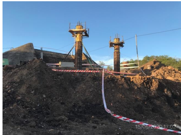
Ilustración 5 – P01, viejo puente sobre A° Malo demolido
