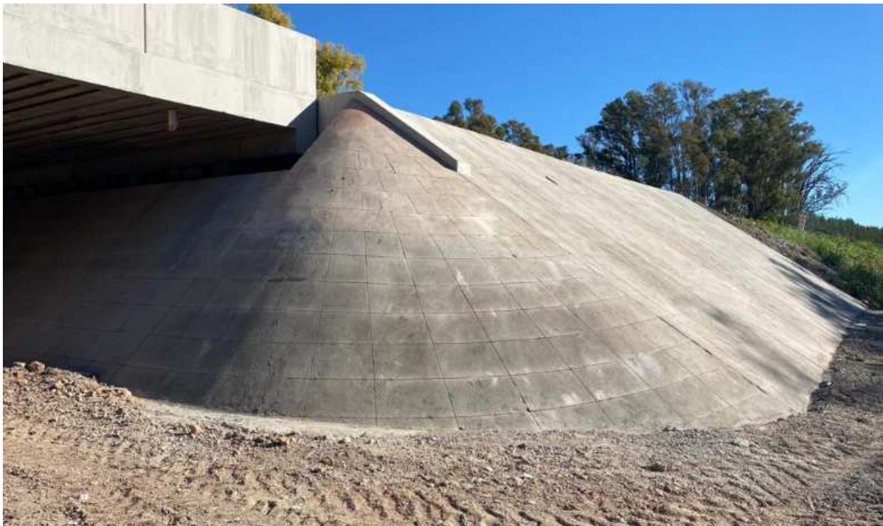
Imagen 1 – Revestimiento con losetas de hormigón
