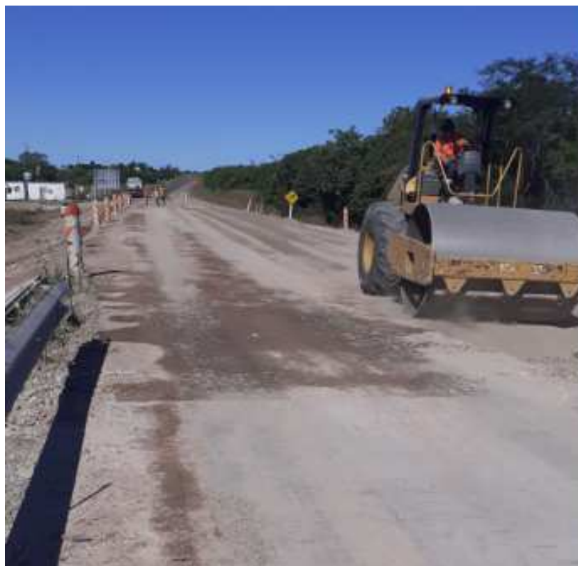
Imagen 3 – Compactación de material granular con cemento portland
