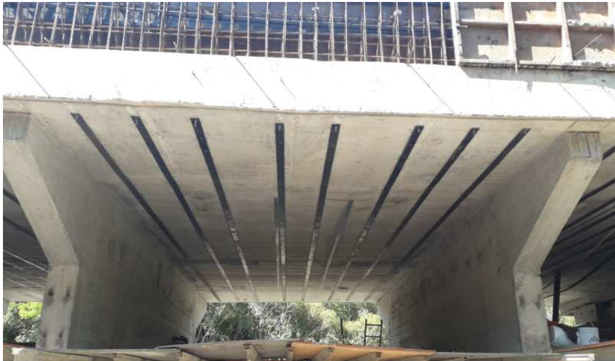
Imagen 2 – Colocación de chapas de acero corten
