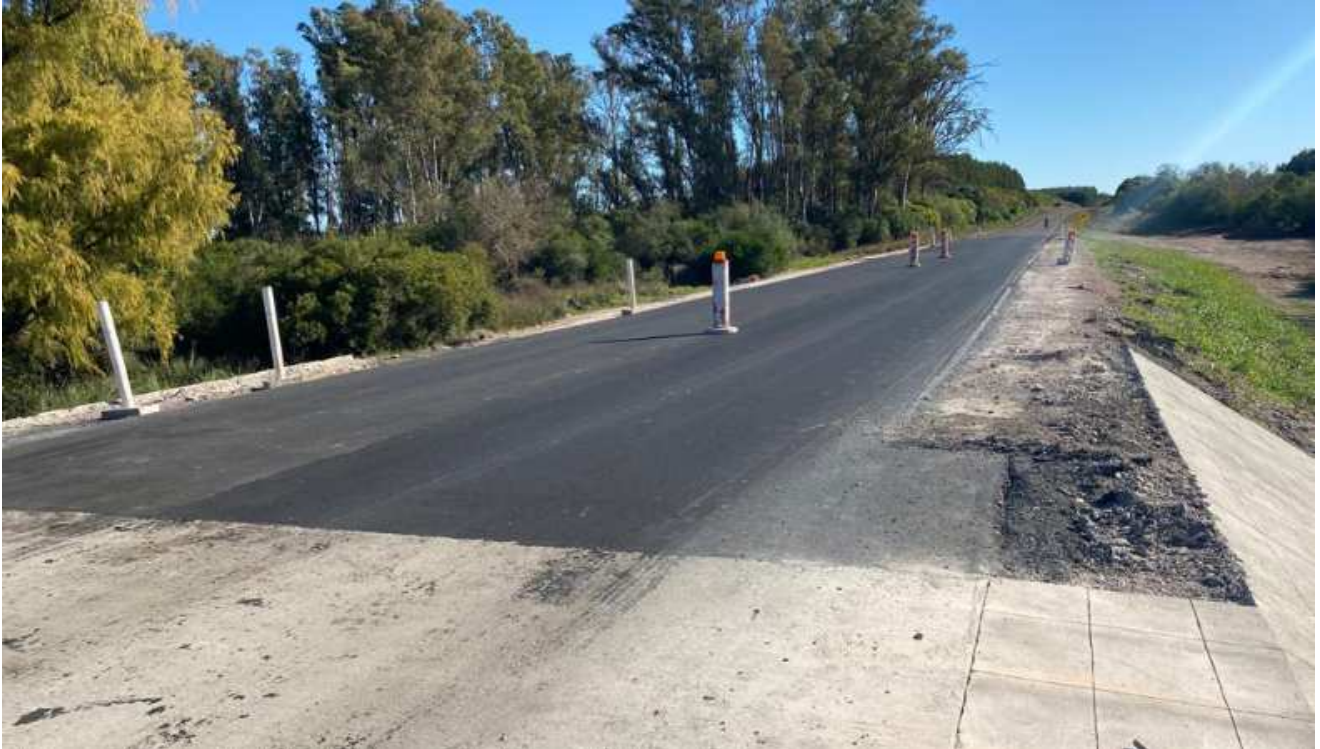
Imagen 4 – Colocación de chapas de acero corten
