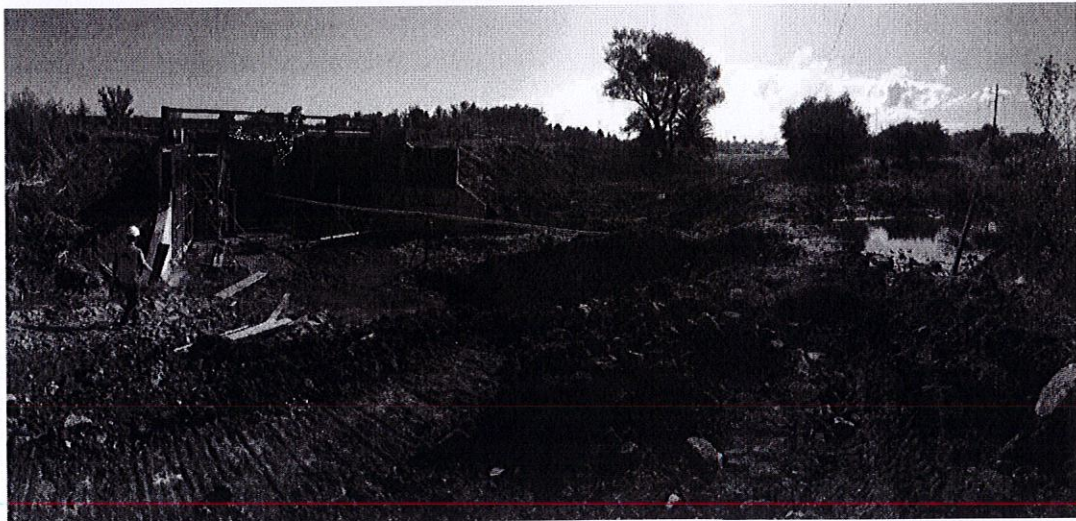
Medición en frente de obra, en Puente Juncal
