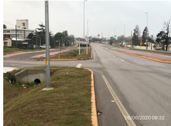
Ilustración 5 – Obras de alcantarillas en cruces de ruta 9 terminadas, Pan de Azúcar,
