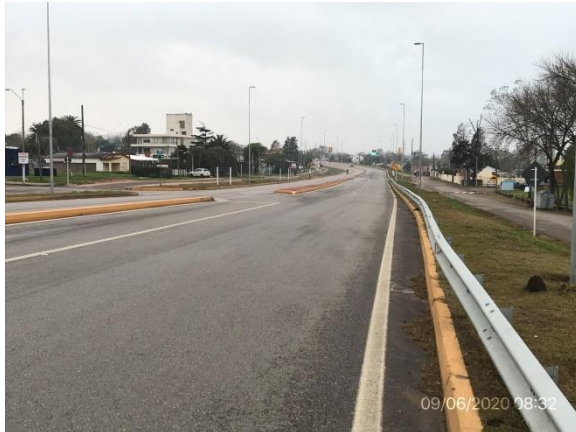
Ilustración 4 – P01, inicio de obras de ruta 9 en Pan de Azúcar
