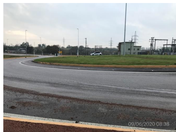
Ilustración 9 – P02, fin de tramo de obras de ruta 9 en Pan de Azúcar. Rotonda con calle Rincón terminada
