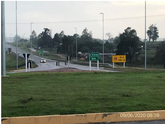
Ilustración 10 – P02, fin de tramo de obras de ruta 9 en Pan de Azúcar. Rotonda con calle Rincón terminada
