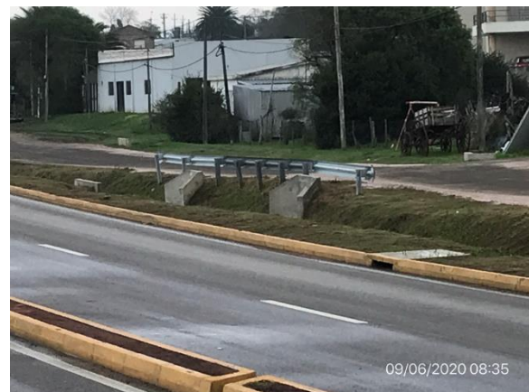
Ilustración 7 – Obras de calles accesorias a ruta 9 terminadas, Pan de Azúcar
