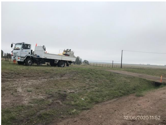
Ilustración 6 – P03, Ruta 5 progresiva 223K000. Trabajos de demarcación para señalización horizontal
