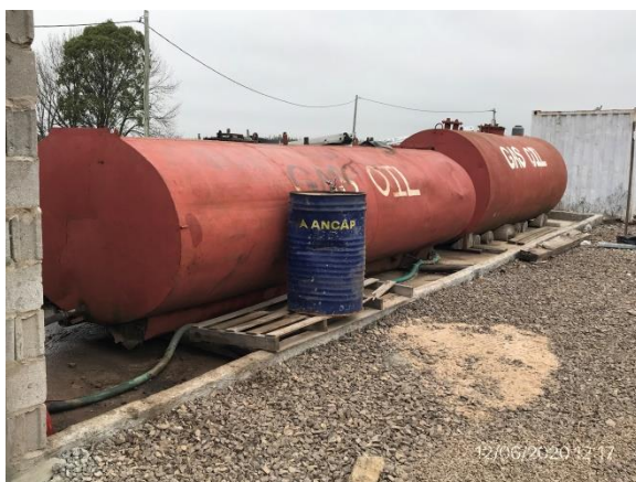
Ilustración 14 – P05. Obrador. Depósitos de Gas Oil con envallado perimetral.
