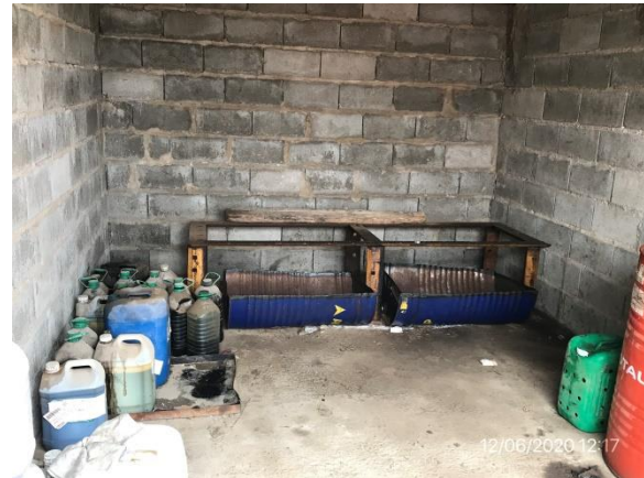
Ilustración 13 – P05 Obrador. Depósito de lubricantes bajo techo y con bandejas metálicas para prevención de derrames.
