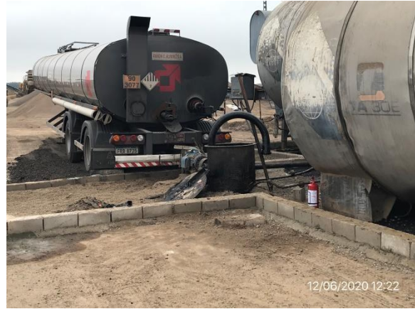
Ilustración 23 – P05. Planta asfáltica. Depósitos de emulsiones y caldera con envallado perimetral.
