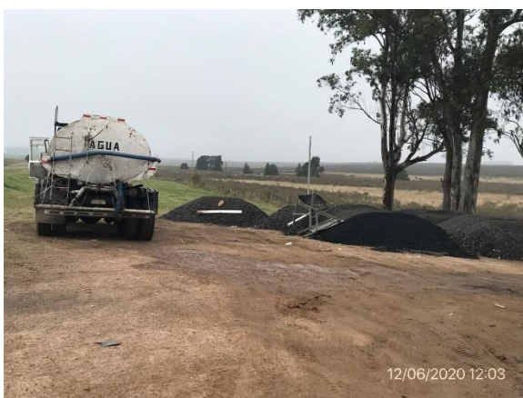
Ilustración 8 – P04, Ruta 5 progresiva 203K000. Campamento provisional, acopio de áridos
