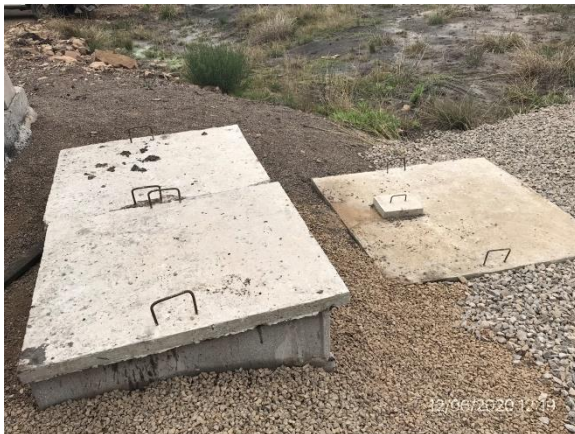
Ilustración 18 – P05. Obrador. Trampa de grasas en sector de lavado.
