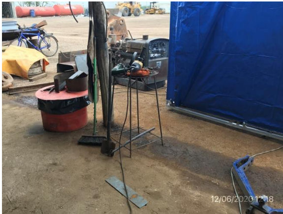
Ilustración 16 – P05. Obrador. Zona de taller mecánico con pavimento impermeable.
