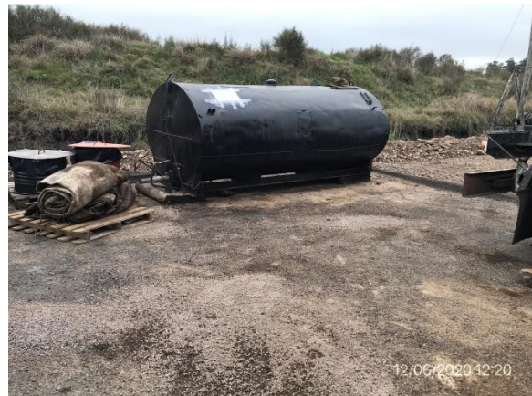
Ilustración 19 – P05. Obrador. Depósito de emulsión asfáltica con pavimento impermeable y envallado perimetral.
