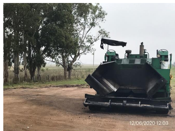
Ilustración 9 – P04, Ruta 5 progresiva 203K000. Campamento provisional, estacionamiento de maquinaria.
