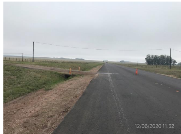
Ilustración 7 – P03, Ruta 5 progresiva 223K000. Trabajos de demarcación para señalización horizontal
