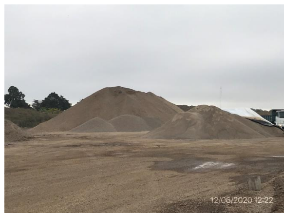
Ilustración 21 – P05. Planta asfáltica. Sector de acopio de áridos triturados.
