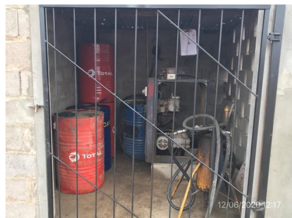
Ilustración 15 – P05. Obrador. Surtidor de combustible techado y envallado.
