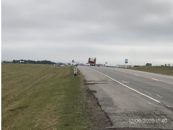
Ilustración 4 – P02, Ruta 5 progresiva 245K000. Fin de tramo
