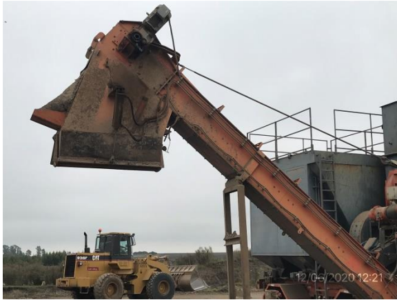
Ilustración 22 – P05. Planta asfáltica. Filtro de mangas.
