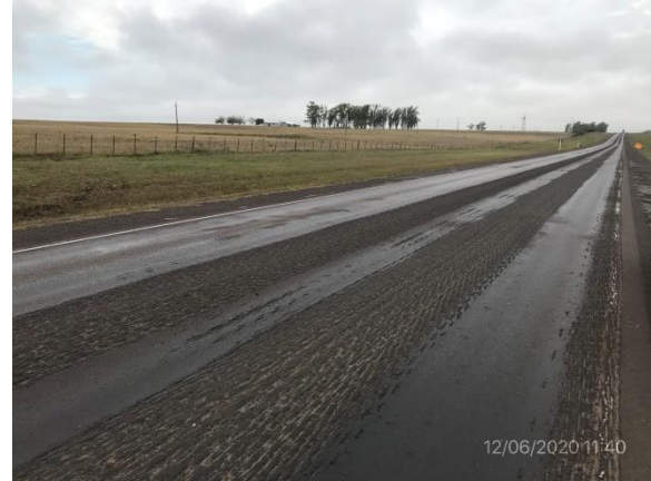
Ilustración 5 – Ruta 5, trabajos de escarificado en ejecución.
