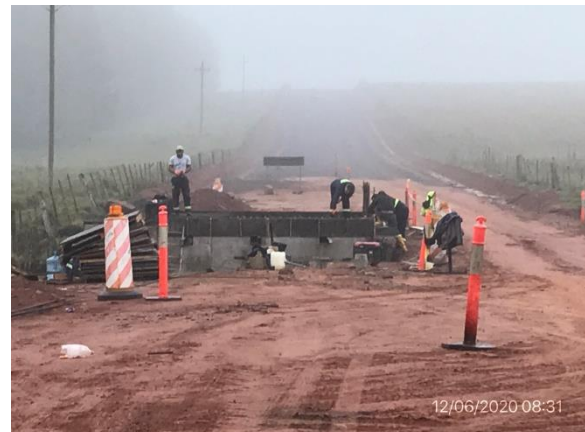
Ilustración 7 – P03, nueva alcantarilla en construcción, Cno. de la Balsa sobre Cda. de Doña Ana.
