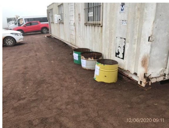
Ilustración 13 – P05, obrador. Canales para segregación de residuos por canal de generación.
