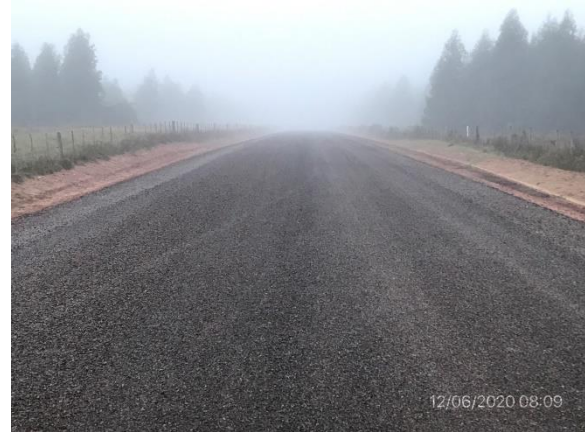
Ilustración 5 – P01, Inicio de tramo, Camino a la Balsa progresiva 6K000.
