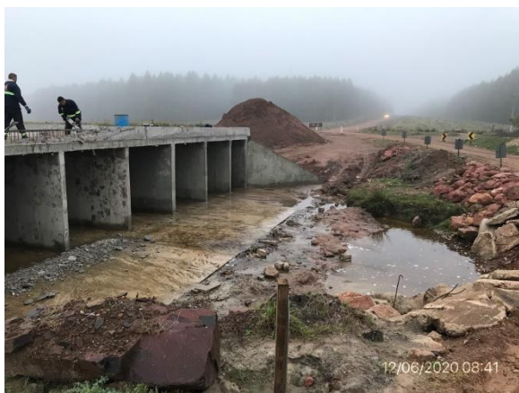
Ilustración 10 – P04, nueva alcantarilla en construcción, Cno. de la Balsa sobre Cda. de La Tranquera.
