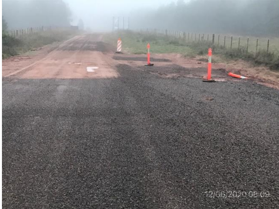
Ilustración 4 – P01, Inicio de tramo, Camino a la Balsa progresiva 6K000.
