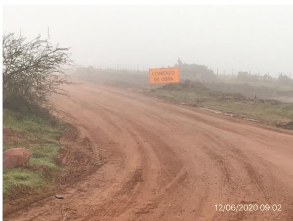
Ilustración 12 – Tramo de Cno. de la Balsa en obra.
