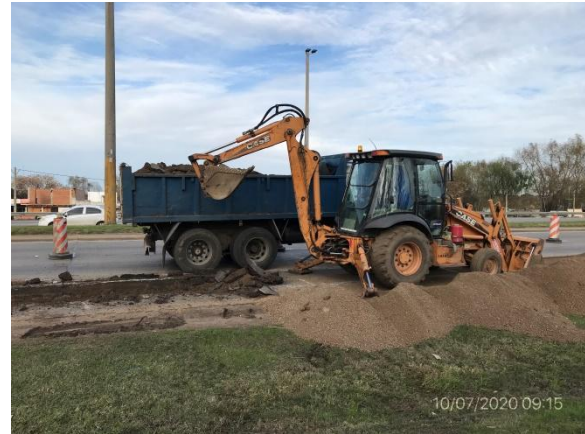
Ilustración 11 – P04 - Frente de obras: reparación de cordones y cantero central en intercambiador Rutas 1 y 5 con Av. Santín Carlos Rossi.
