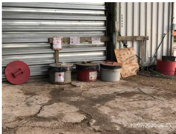
Ilustración 5 – P03, Obrador - acopio de residuos segregados por canal de generación
