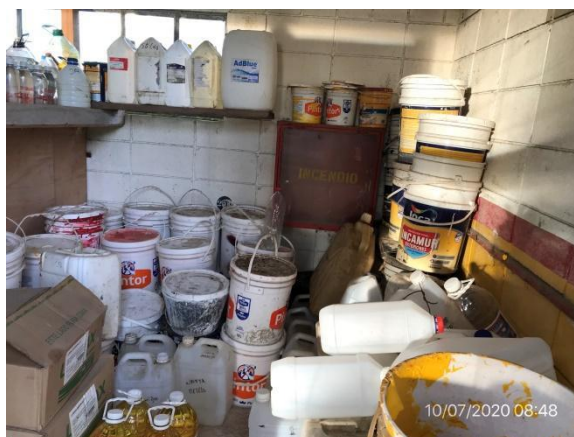
Ilustración 9 – P03, Obrador - sector cerrado y techado para acopio de pinturas y solventes.
