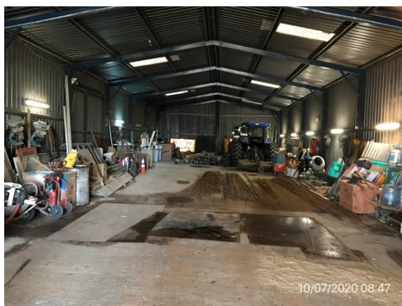
Ilustración 7 – P03, Obrador - pañol techado con pavimento impermeable.
