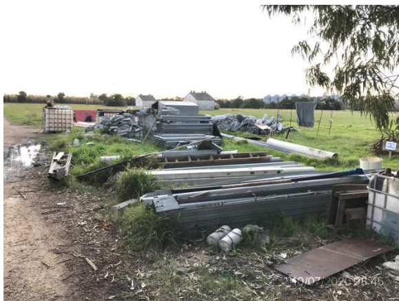
Ilustración 4 – P03, Obrador - acopio de defensas metálicas
