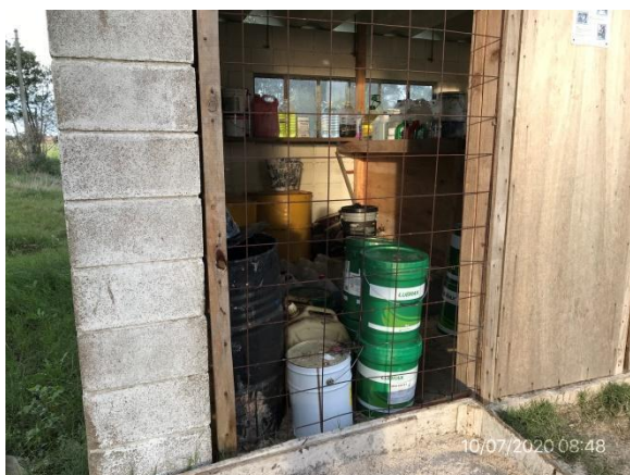
Ilustración 8 – P03, Obrador - sector cerrado y techado para acopio de lubricantes
