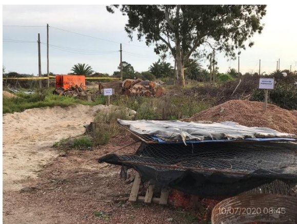
Ilustración 6 – P03, Obrador - explanada de acopio de áridos
