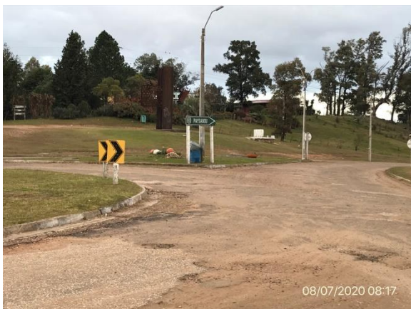
Ilustración 14 – P02, fin de tramo, Ruta 90 progresiva 89K200, Guichón
