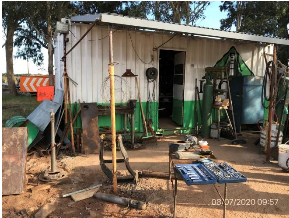
Ilustración 10 – P03, obrador. Taller mecánico de reparaciones menores con pavimento impermeable.
