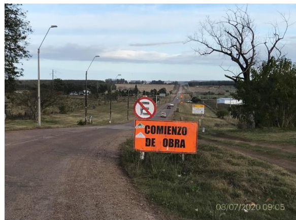
Ilustración 15 – P02, fin de tramo, Ruta 90 progresiva 89K200, Guichón.
