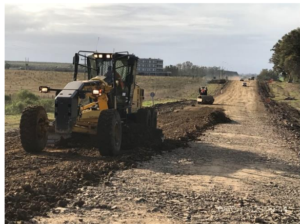
Ilustración 19 – Ruta 90, frente de obras.
