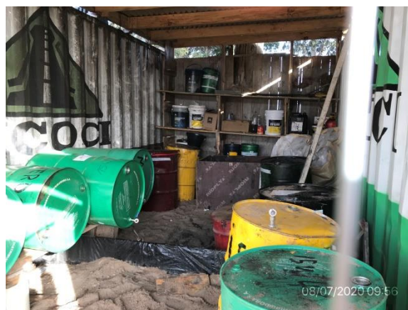
Ilustración 9 – P03, obrador. Sector techado y con pavimento impermeable para trasiego de lubricantes
