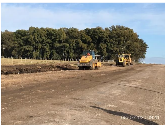
Ilustración 20 – Ruta 90, frente de obras.
