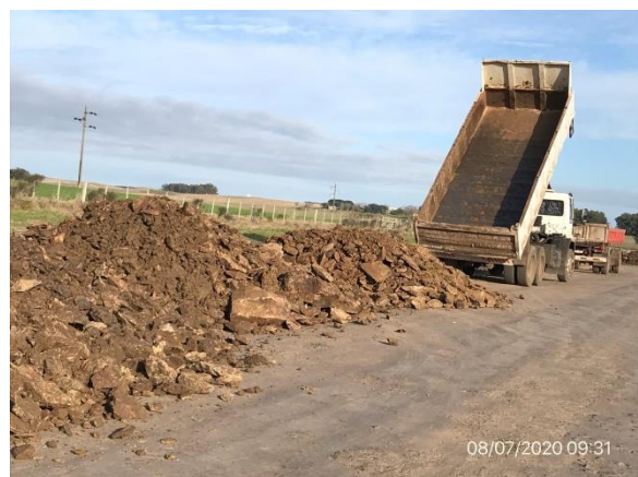
Ilustración 21 – Ruta 90, frente de obras.
