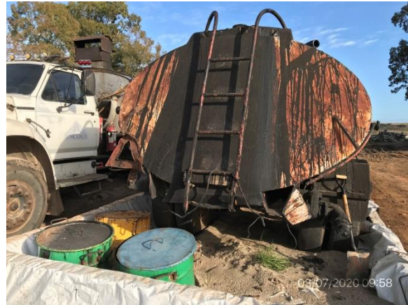
Ilustración 11 – P03, obrador. Depósito de emulsiones asfálticas con envallado perimetral y pavimento impermeabilizado
