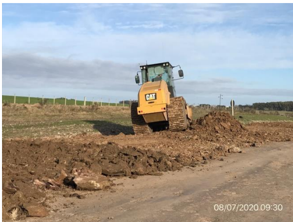
Ilustración 18 – Ruta 90, frente de obras.
