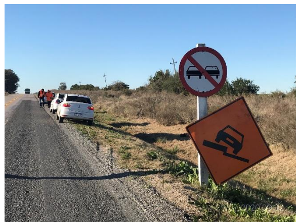
Ilustración 9 – P13, Frente de obras. Bacheo en ejecución, Ruta 12 progresiva 23K300.
