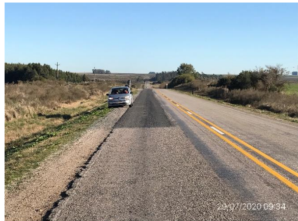
Ilustración 7 – Obras de bacheo terminadas en sendas a (+) de Ruta 12, progresiva 15K800
