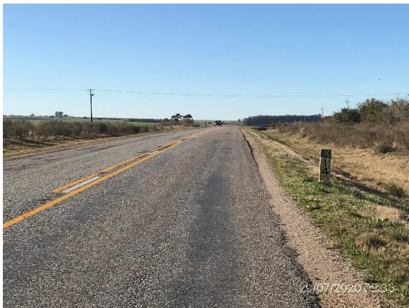
Ilustración 6 – Obras de bacheo terminadas en ambas sendas de Ruta 12, progresiva 14K000
