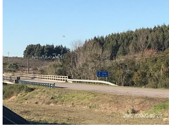
Ilustración 5 – Acopio de áridos en Ruta 12 progresiva 11K900 a (-), A° Arias
