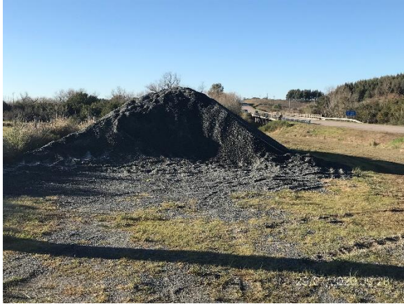
Ilustración 4 – Acopio de áridos en Ruta 12 progresiva 11K900 a (-), A° Arias
