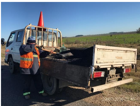
Ilustración 8 – P13, Frente de obras. Bacheo en ejecución, Ruta 12 progresiva 23K300.
