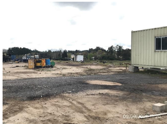
Ilustración 9 – P03, Obrador desmontado
