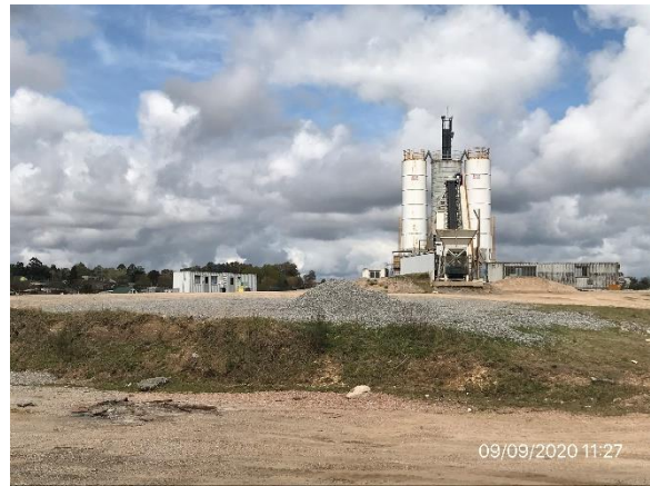
Ilustración 13 – P03, Planta de hormigón de la subcontratista Hormigones Artigas SA sin desmontar.
