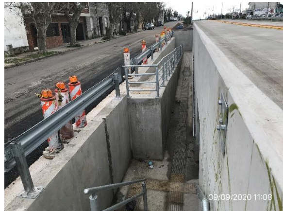
Ilustración 7 – Trabajos culminados en pasaje peatonal bajo Ruta 5, planta urbana de Durazno
