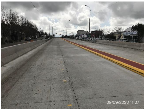
Ilustración 8 – Trabajos culminados en Ruta 5, en su pasaje por la planta urbana de Durazno
