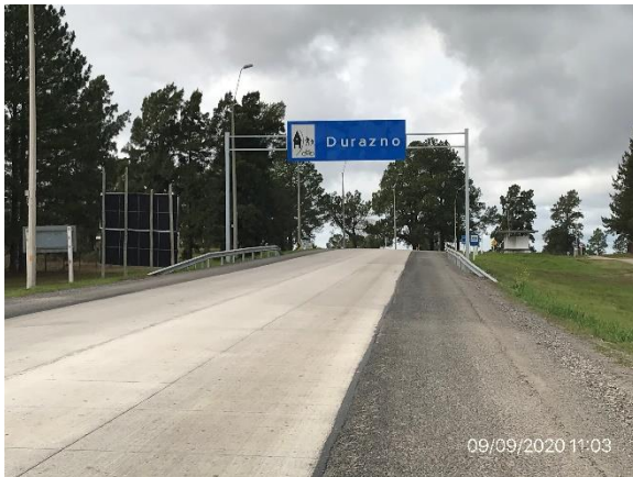
Ilustración 6 – Trabajos culminados en Ruta 5, en su pasaje por la planta urbana de Durazno
