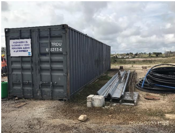
Ilustración 12 – P03, Obrador desmontado,
