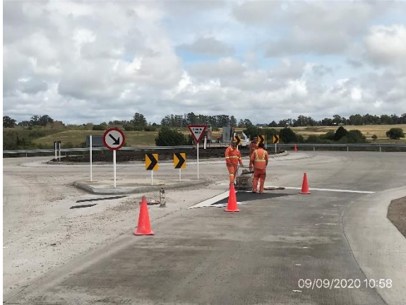
Ilustración 4 – P02, Rotonda norte Rutas 5 y 14, trabajos de señalización en ejecución.
