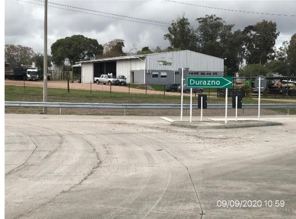
Ilustración 5 – P02, Rotonda norte Rutas 5 y 14, trabajos de señalización en ejecución
