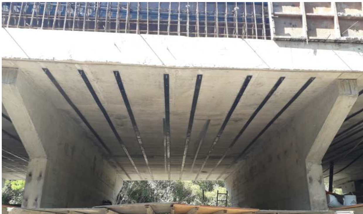
Imagen 2 – Colocación de chapas de acero corten
