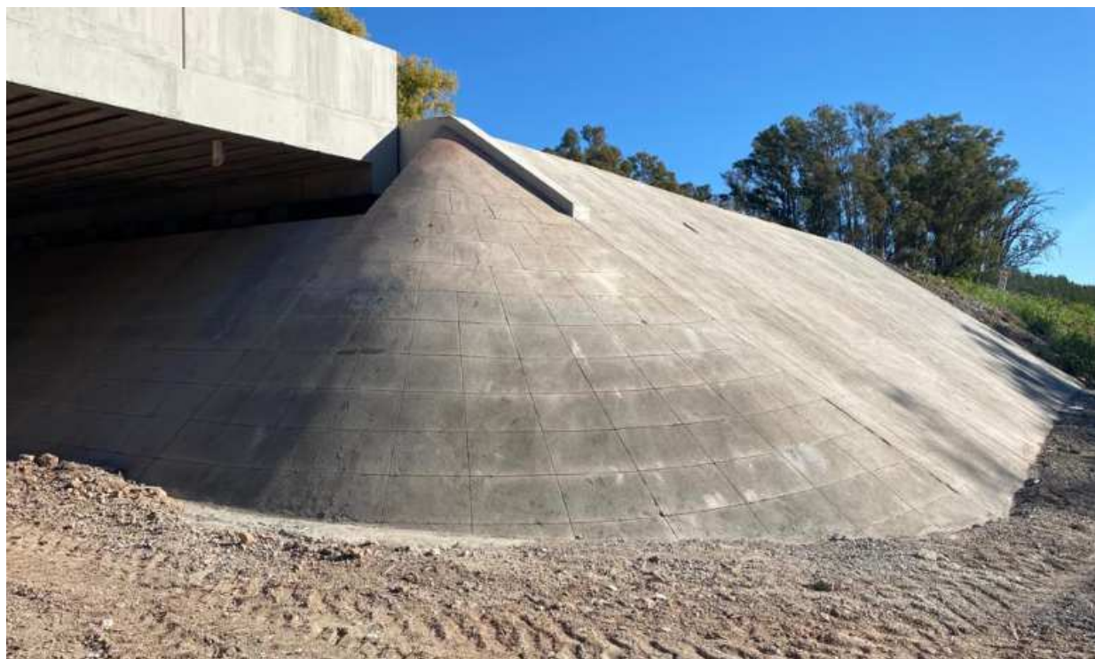
Imagen 1 – Revestimiento con losetas de hormigón
