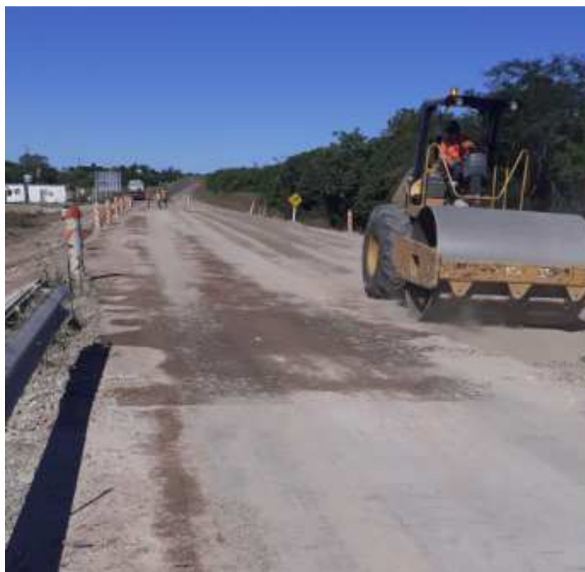
Imagen 3 – Compactación de material granular con cemento portland
