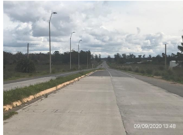
Ilustración 5 – Ruta 11, obras ejecutadas.
