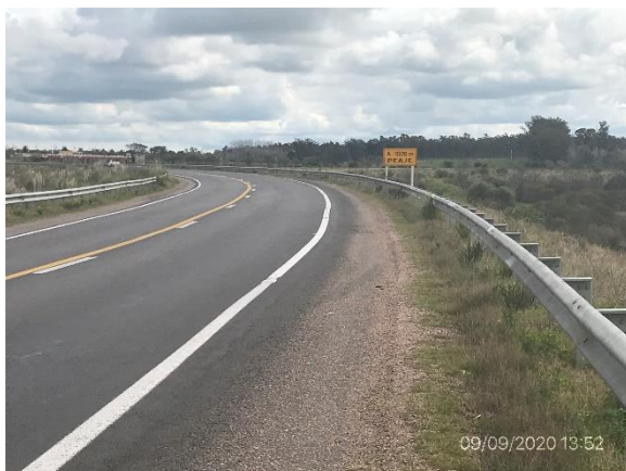
Ilustración 6 – Ruta 11, obras ejecutadas
