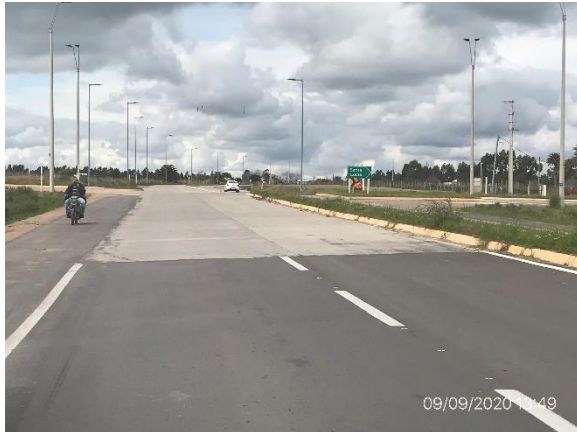
Ilustración 4 – P01, inicio de tramo. Ruta 11 progresiva 84K150, intersección con Ruta 63.
