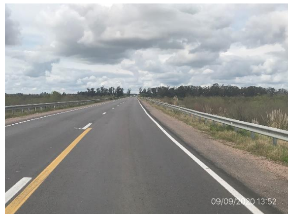
Ilustración 7 – Ruta 11, obras ejecutadas
