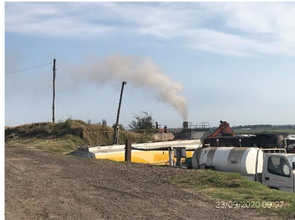
Ilustración 11 – P03 Planta Asfáltica. Emisiones abundantes de humos por falta de filtros en chimenea
