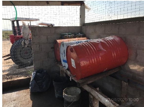
Ilustración 13 – P03 Obrador. Depósito de lubricantes bajo techo y con vallado perimetral para prevención de derrames.
