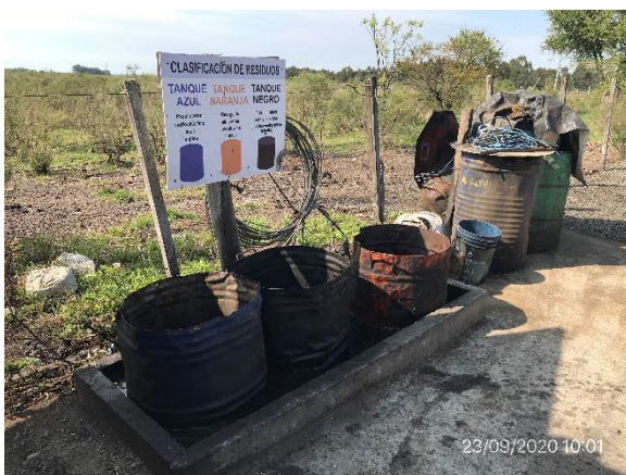
Ilustración 14 – P03, Obrador. Depósitos de residuos segregados por canal de generación
