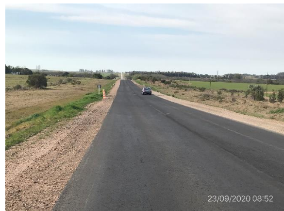
Ilustración 7 – P05, Frente de obras
