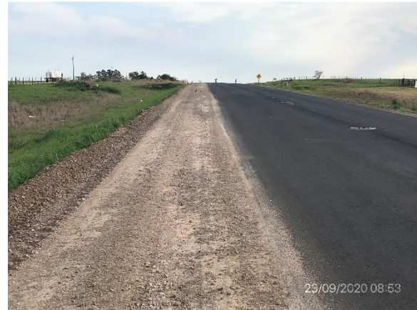
Ilustración 5 – Ruta 3, trabajos en ejecución en media calzada.
