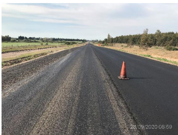
Ilustración 8 – P05, Frente de obras
