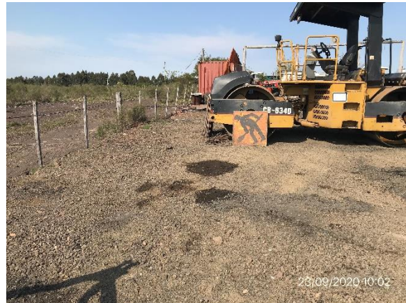
Ilustración 17 – P03, Obrador. Estacionamiento de maquinaria pavimento granular para retención de aceites.
