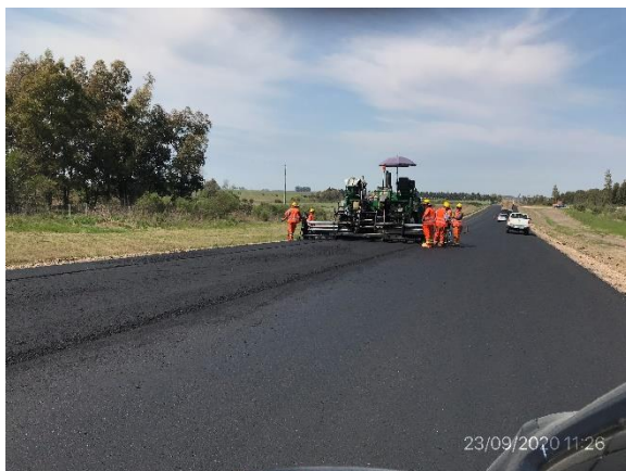
Ilustración 6 – P05, Frente de obras
