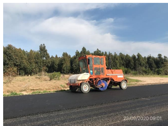
Ilustración 9 – P05, Frente de obras.
