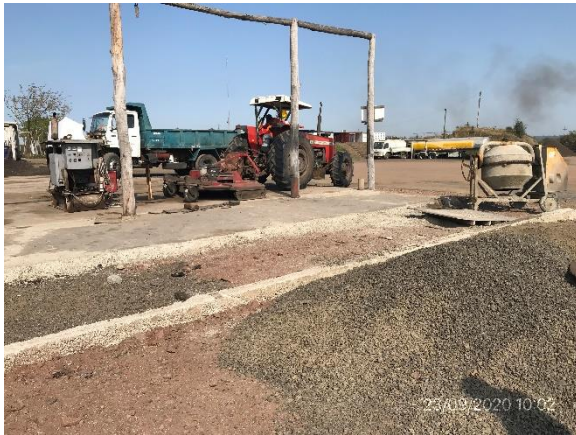
Ilustración 16 – P03, Obrador. Zona de lavado de maquinaria en construcción.
