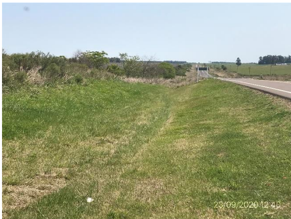
Ilustración 6 – Ruta 26, conformación de taludes y drenajes de faja pública concluidos, con recuperación de empastado
