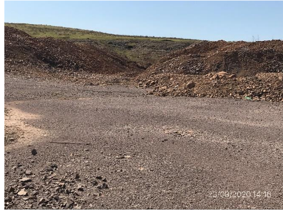
Ilustración 11 – P03, cantera con piso regularizado y pendientes conformadas
