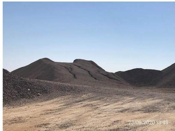
Ilustración 7 – P03, obrador. Acopio de basalto triturado.
