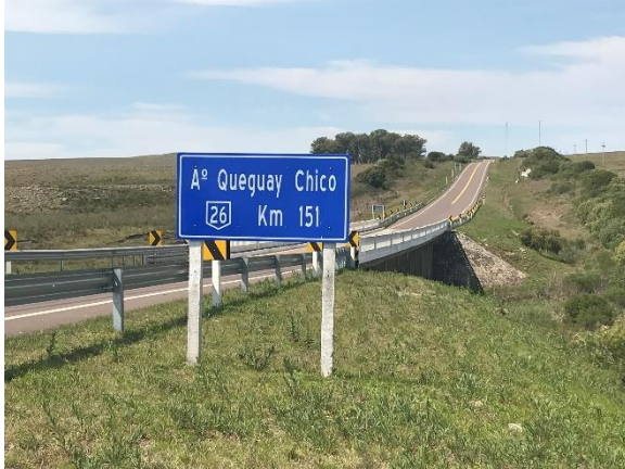
Ilustración 4 – P01, Inicio de tramo sobre Ruta 26 progresiva 151K000, Ao Queguay Chico
