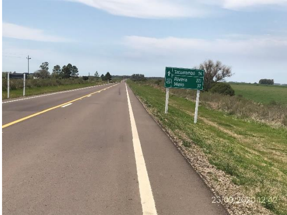
Ilustración 4 – P01, Inicio de tramo sobre Ruta 26 progresiva 113K000,
