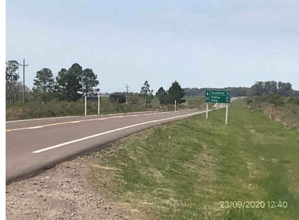
Ilustración 5 – Ruta 26, obras obligatorias terminadas con tareas de recuperación ambiental realizadas sobre faja de Ruta 26.
