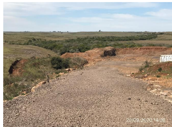
Ilustración 9 – P03, cantera con tareas de remediación ambiental realizadas.
