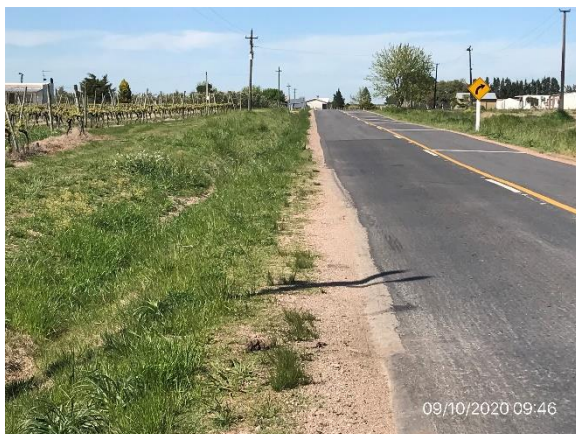
Ilustración 6 – Obras terminadas en Ruta 66 con tareas de recuperación de faja realizadas
