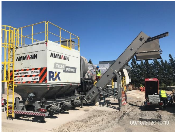
Ilustración 10 – P03. Nueva planta asfáltica, en proceso de puesta en marcha
