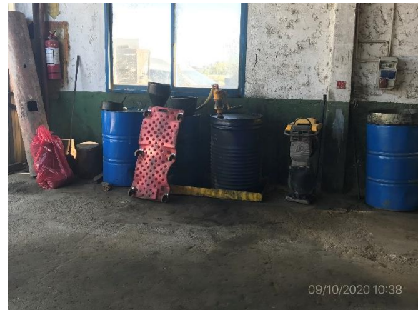
Ilustración 19 – P03. Obrador. Acopio de lubricantes con bandejas y bajo techo
