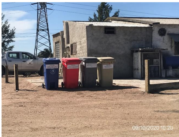
Ilustración 12 – P03. Obrador. Nuevo puesto de segregación de residuos con tapa
