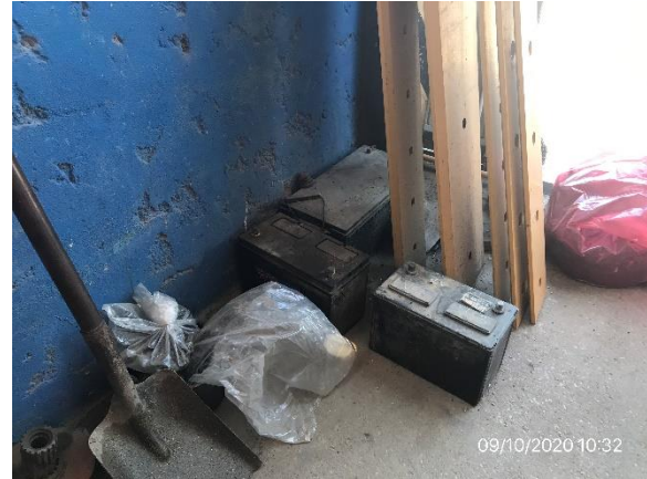
Ilustración 17 – P03. Obrador. Acopio de baterías sobre pavimento impermeable
