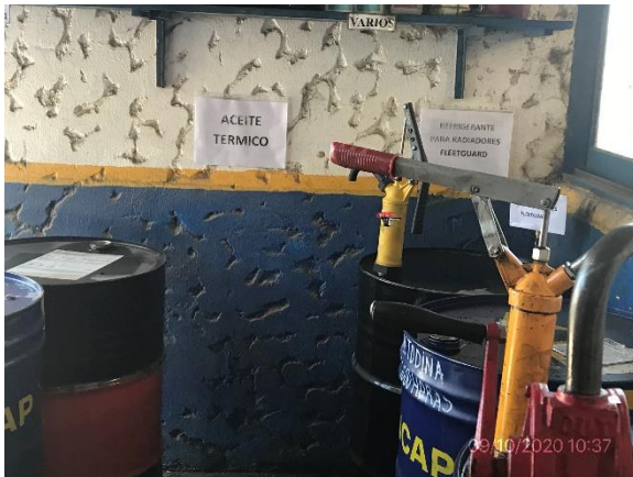
Ilustración 18 – P03. Obrador. Sector de trasiego de lubricantes bajo techo y con pavimento impermeable y envallado
