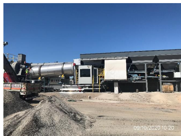
Ilustración 9 – P03. Nueva planta asfáltica, en proceso de puesta en marcha
