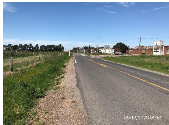
Ilustración 7 – P02, Fin de tramo en Ruta 66, empalme con Ruta 67
