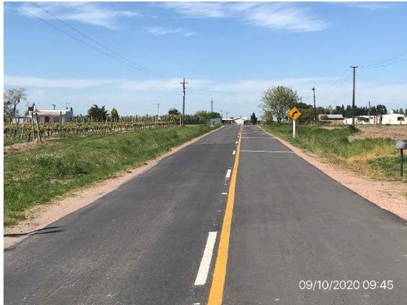
Ilustración 4 – P01, Inicio de tramo en Ruta 66, empalme con Ruta 32
