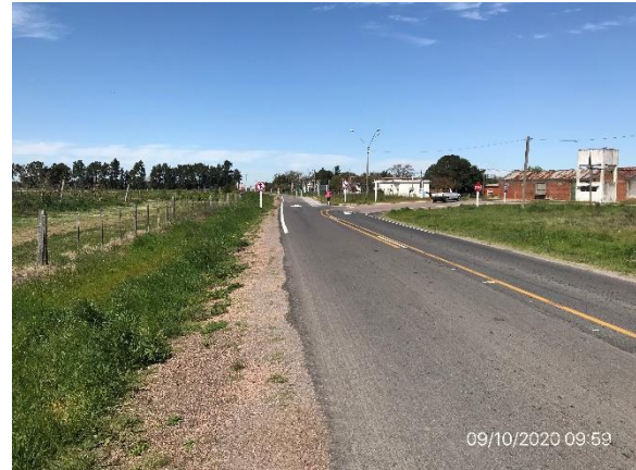
Ilustración 5 – Obras terminadas en Ruta 66 con tareas de recuperación de faja realizadas
