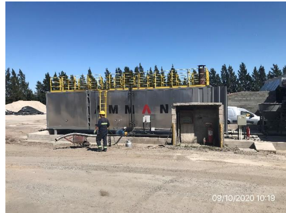
Ilustración 11 – P03. Nueva planta asfáltica con envallado perimetral en zona de acopio de emulsiones
