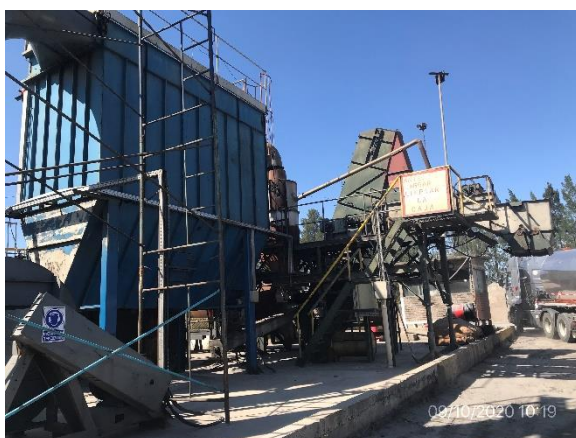
Ilustración 8 – P03. Obrador. Planta asfáltica antigua fuera de uso
