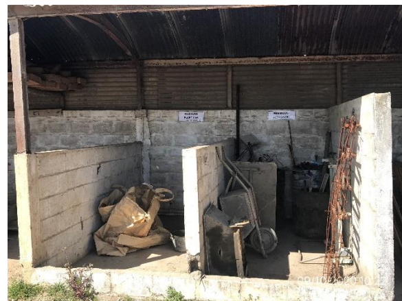
Ilustración 13 – P03. Obrador. Sector de acopio de residuos ferrosos y plásticos
