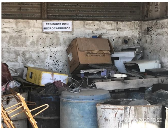
Ilustración 14 – P03. Obrador. Sector de acopio de residuos con hidrocarburos mezclados con residuos de otro tipo.
