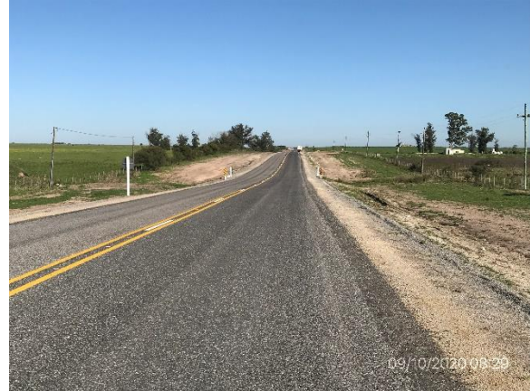
Ilustración 5 – tramo de Ruta 65 terminado con tareas de recuperación ambiental realizadas
