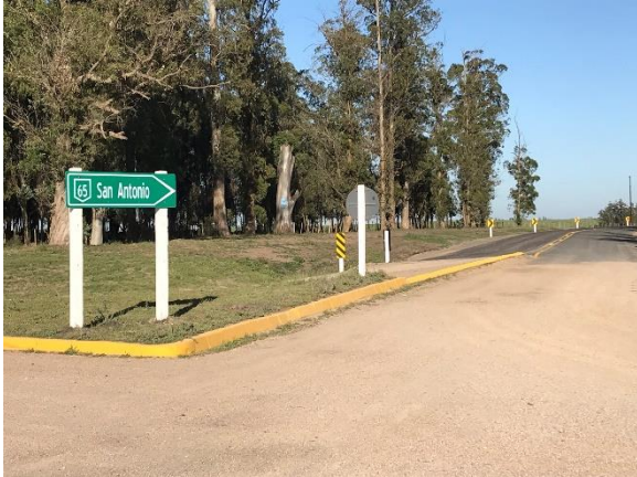
Ilustración 4 – P02a, Fin de tramo de obras en Ruta 65
