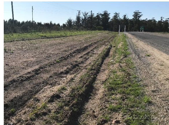
Ilustración 7 – Obras terminadas en Ruta 65 con taludes revestidos con suelo vegetal y empastado en proceso.
