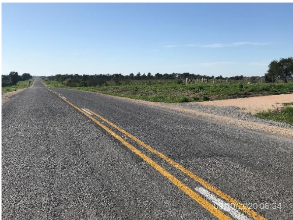
Ilustración 6 – tramo de Ruta 65 terminado con tareas de recuperación ambiental realizadas
