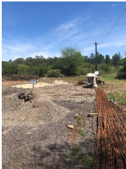
Ilustración 6 – P03, Obrador, acopio de áridos
