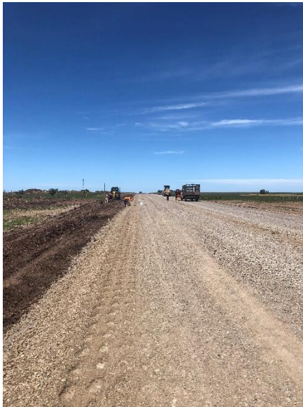
Ilustración 14 – Frente de obras.
