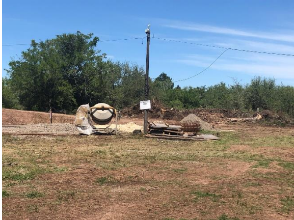
Ilustración 4 – P03, Obrador, acopio de materiales de obra
