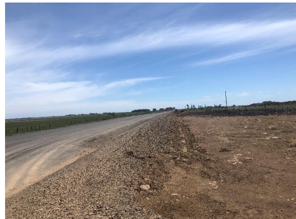
Ilustración 13 – Imprimación ejecutada en el tramo objeto del contrato.
