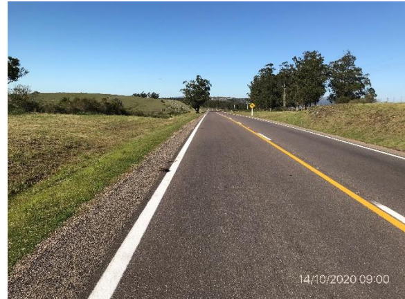
Ilustración 5 – Obras terminadas en Ruta 60 con tareas de recuperación de faja realizadas
