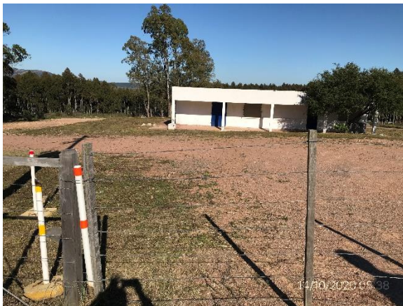
Ilustración 12 – P04. Obrador principal desmontado.
