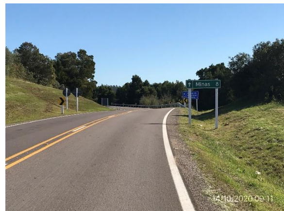
Ilustración 7 – P02, Fin tramo de obra Ruta 60 progresiva 50K000, inicio tramo de obra en Ruta 12 progresiva 351K900
