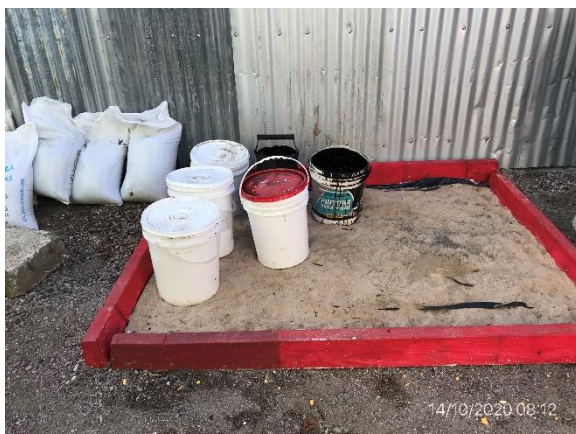
Ilustración 8 – P05. Obrador de mantenimiento. Pan de Azúcar. Envallado para recipientes con productos asfálticos
