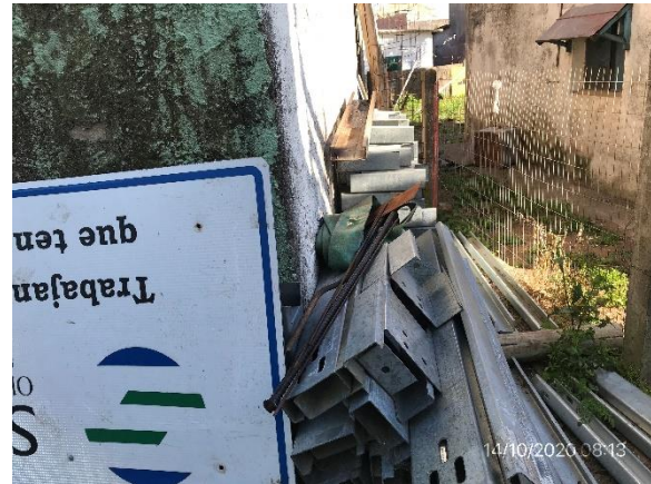
Ilustración 11 – P05. Obrador de mantenimiento. Pan de Azúcar. Acopio de insumos para defensas metálicas
