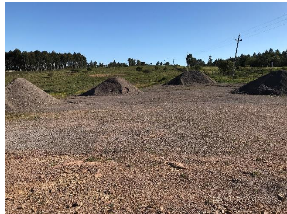
Ilustración 13 – P04. Obrador principal desmontado, con acopios de material granular a disposición de la empresa y con autorización de DNV – MTOP.
