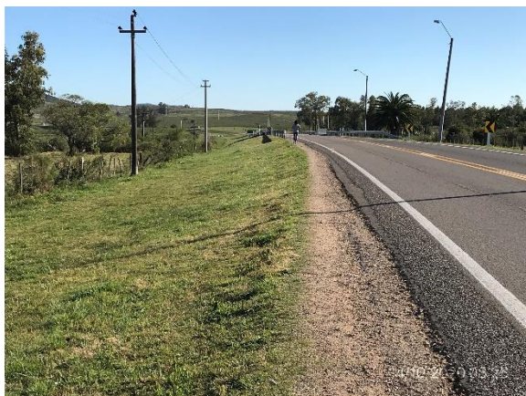
Ilustración 6 – Obras terminadas en Ruta 60 con tareas de recuperación de faja realizadas
