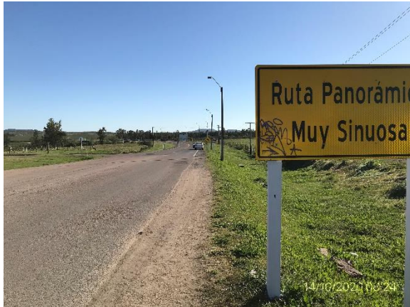
Ilustración 4 – P01, Inicio de tramo en Ruta 60, progresiva 12K000
