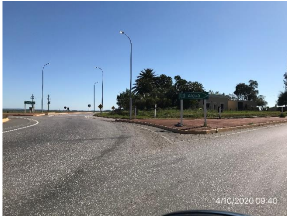
Ilustración 4 – P03, Inicio de obras en Ruta 13, empalme entre Ruta 8 y 13, progresiva 150K400.
