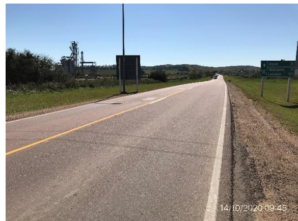
Ilustración 7 – Obras en Ruta 13 culminadas con tareas de recuperación ambiental realizadas.
