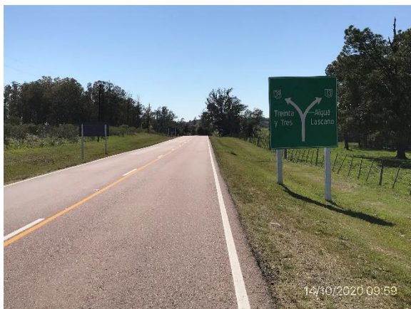
Ilustración 6 – P02, fin de tramo de obras en Ruta 39, empalme con Ruta 13.
