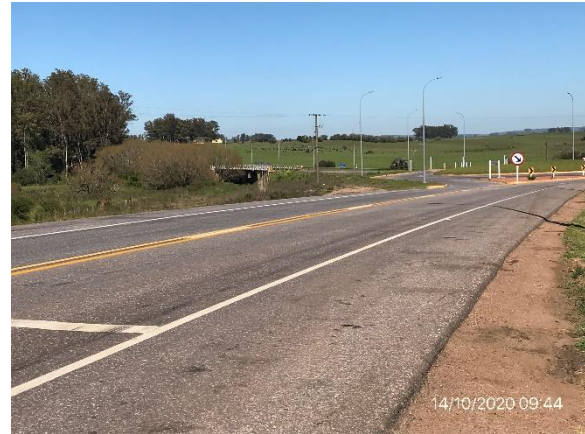
Ilustración 5 – P03, Inicio de obras en Ruta 13, empalme entre Ruta 8 y 13, progresiva 150K400.
