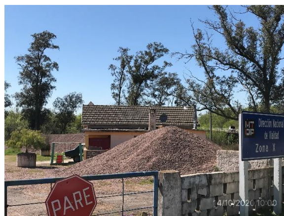
Ilustración 8 – P05, Destacamento Regional 10 – MTOP/DNV, campamento de H&G SA para la culminación de las obras de mantenimiento.
