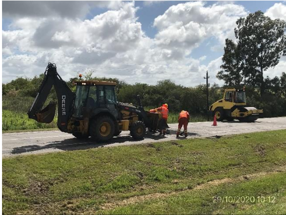
Ilustración 4 – P06, Frente de obras
