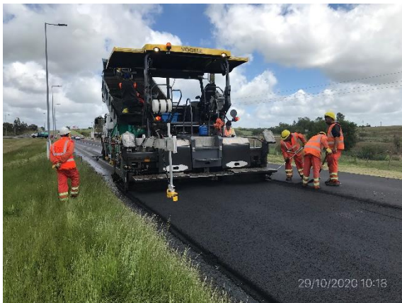
Ilustración 6 – P06, Frente de obras
