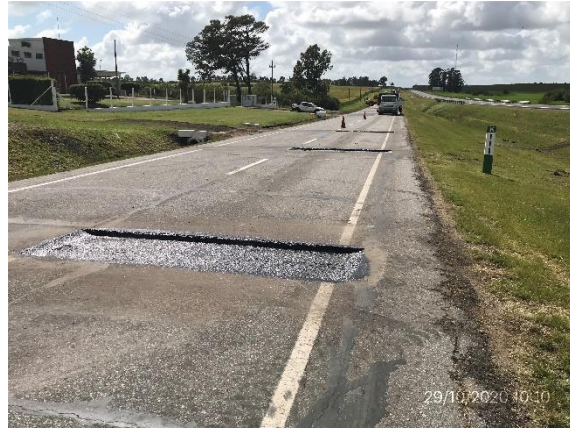
Ilustración 5 - P06, Frente de obras
