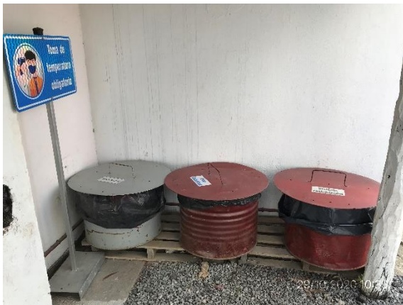
Ilustración 18 - P03, Obrador secundario. Segregación de residuos no domésticos
