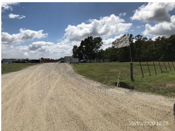
Ilustración 8 – P03 – Obrador secundario, vista general.
