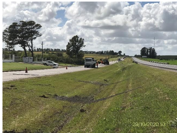
Ilustración 7 – P06, Frente de obras
