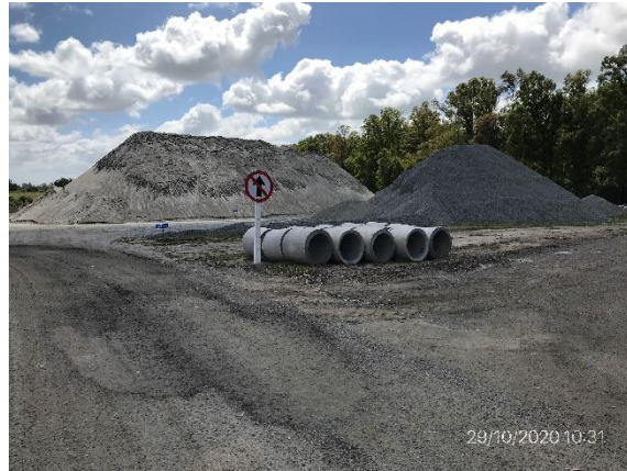
Ilustración 11 – P03, Obrador secundario. Depósito de áridos.
