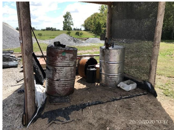
Ilustración 15 – P03, Obrador secundario. Depósito de arenas contaminadas en recinto techado y envallado
