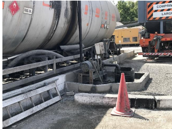
Ilustración 13 P03, Obrador secundario. Planta asfáltica con zona de traspiego de emulsiones asfálticas envallada
