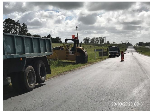
Ilustración 19 - P05, frente de obras. Ruta 1 progresiva 139K000, obras de recapado en ejecución
