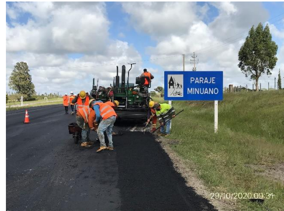
Ilustración 17 – P05, frente de obras. Ruta 1 progresiva 139K000, obras de recapado en ejecución
