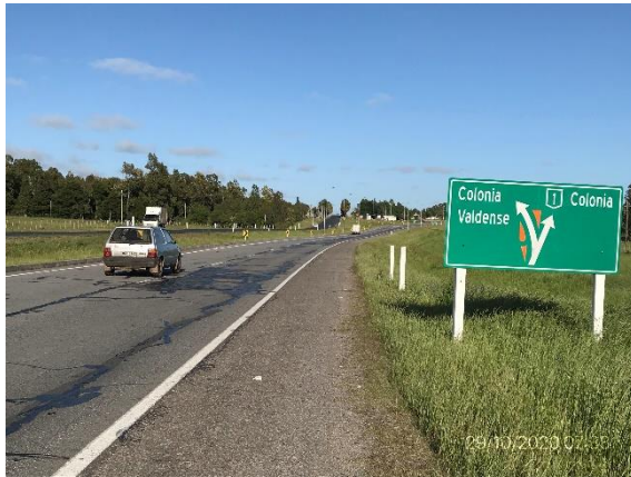
Ilustración 16 - P01. Inicio de Tramo de obras en Ruta 1, progresiva 119K000
