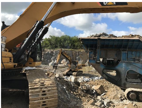
Ilustración 14 - P04, Cantera, padrón rural N° 18.080 de Colonia. Planta de trituración primaria
