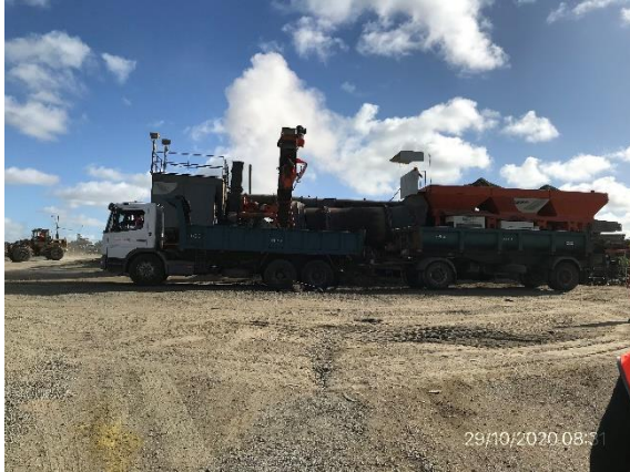
Ilustración 4 – P03 - Obrador. Planta asfáltica con filtro de mangas
