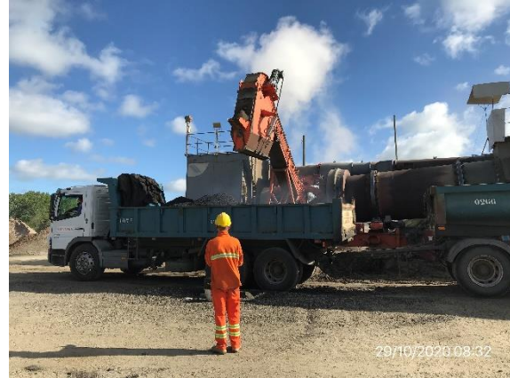
Ilustración 5 - P03 - Obrador. Planta asfáltica con filtro de mangas
