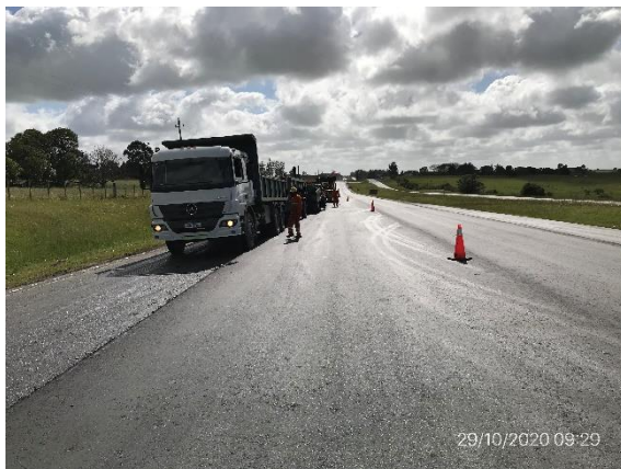
Ilustración 18 - P05, frente de obras. Ruta 1 progresiva 139K000, obras de recapado en ejecución
