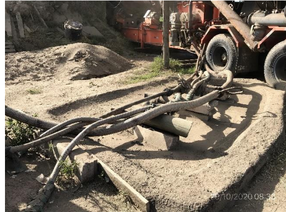
Ilustración 11 – P03, Obrador. Conexiones flexibles entre tanques de emulsión y planta asfáltica sobre suelo compactado envallado.
