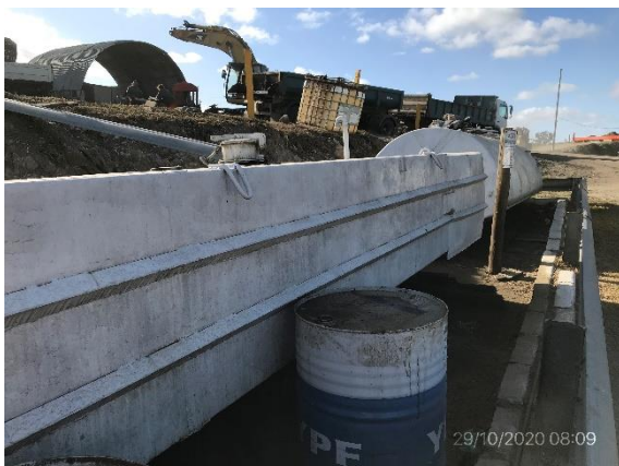
Ilustración 8 – P03 - Obrador. Tanque de combustible con envallado perimetral.
