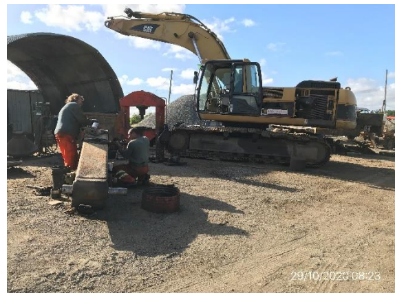
Ilustración 7 – P03 Obrador. Zona de taller de maquinaria a cielo abierto sin pavimento impermeable ni contención envallada de pluviales
