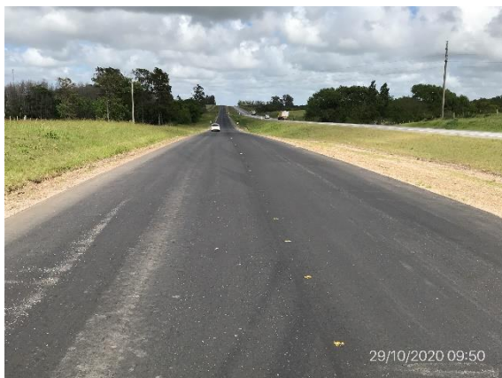
Ilustración 20 – Obras de recapado terminadas en Ruta 1
