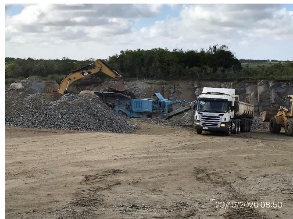
Ilustración 13 - P04, Cantera, padrón rural N° 18.080 de Colonia. Planta de trituración primaria
