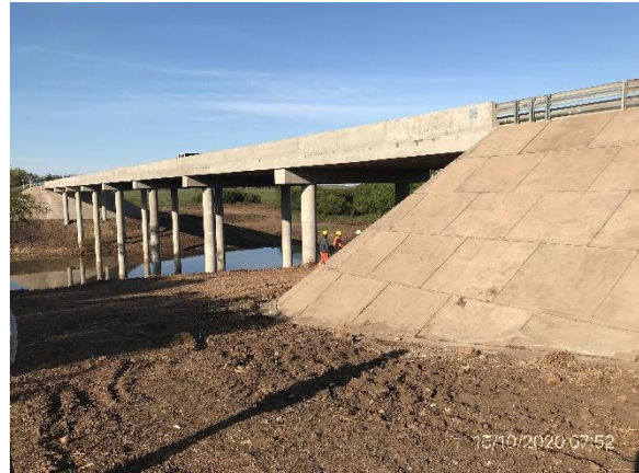
Ilustración 5 – P01, Puente sobre A° Malo con trabajos de recuperación del cauce realizados
