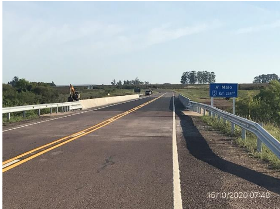
Ilustración 4 – P01, puente sobre A° Malo terminado
