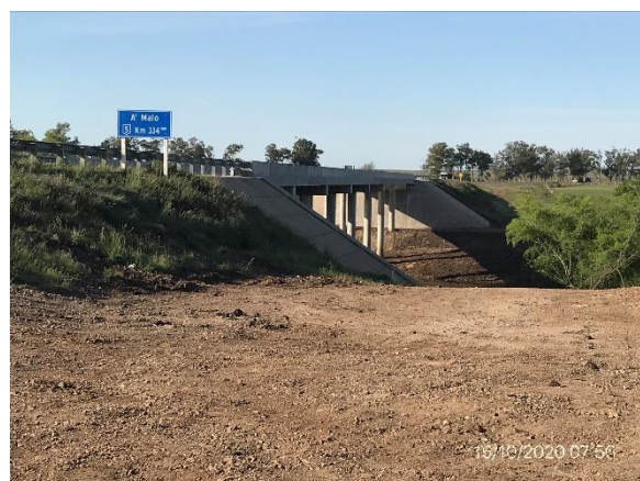
Ilustración 9 – P01, puente sobre A° Malo terminado.
