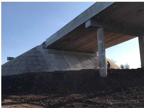
Ilustración 6 – P01, puente sobre A° Malo terminado
