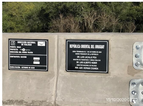
Ilustración 7 – P01, puente sobre A° Malo terminado.
