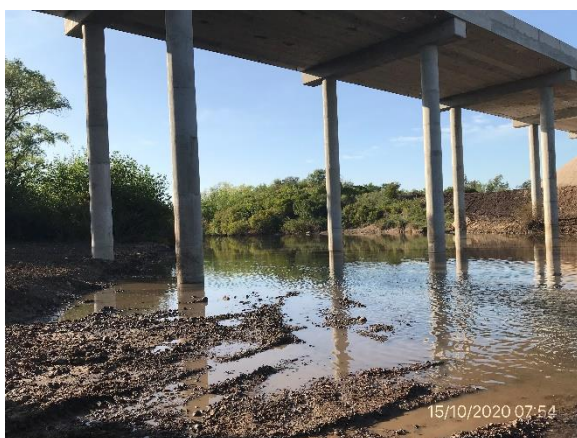
Ilustración 8 – P01, Puente sobre A° Malo con trabajos de recuperación del cauce realizados y ataguías desmontadas.
