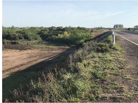
Ilustración 11 – P02. Obrador desmontado con explanada regularizada y obras provisionarias retiradas.
