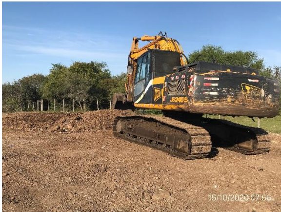
Ilustración 12 – P02. Obrador desmontado con tareas de reconformado de taludes y pendientes en etapa de culminación.
