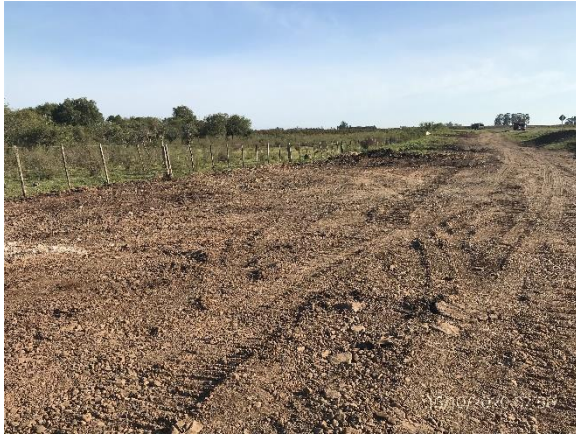
Ilustración 10 – P02. Obrador desmontado con explanada regularizada y obras provisionarias retiradas
