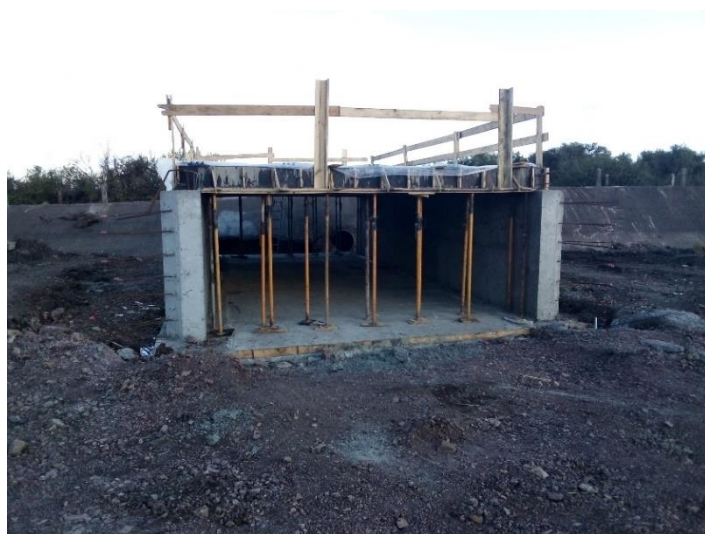
Hormigonado de la losa de la alcantarilla n° 4 3B2 Progresiva 10+700.
