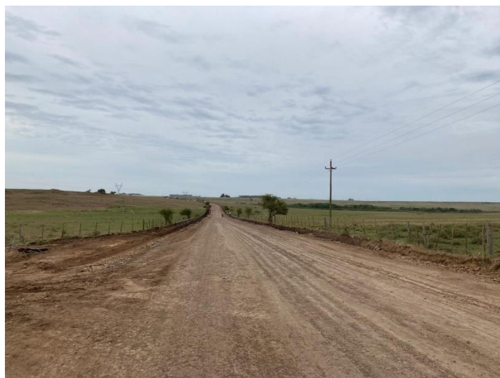
Ensanche y recargo de terraplén. Imagen tomada en progresiva 11+800.
