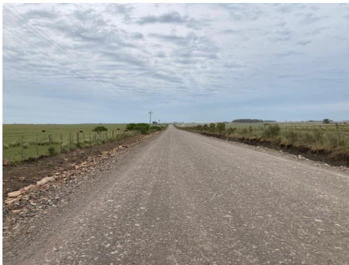
Ensanche y recargo de terraplén. Imagen tomada en progresiva 5+300.
