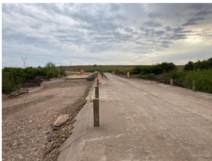
Construcción de una senda del puente y puente existente.
