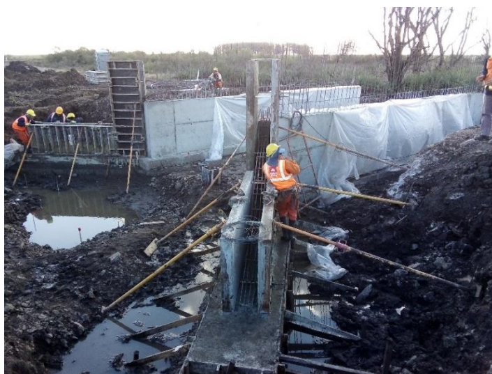
Hormigonado de muros de alcantarilla n° 2 B1.8 Progresiva 3+720.
