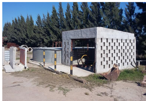
Vista de tanque australiano de agua de pozo
