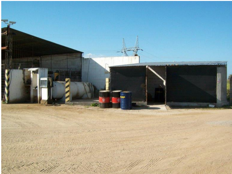
Vista de depósito de combustibles y lubricantes
