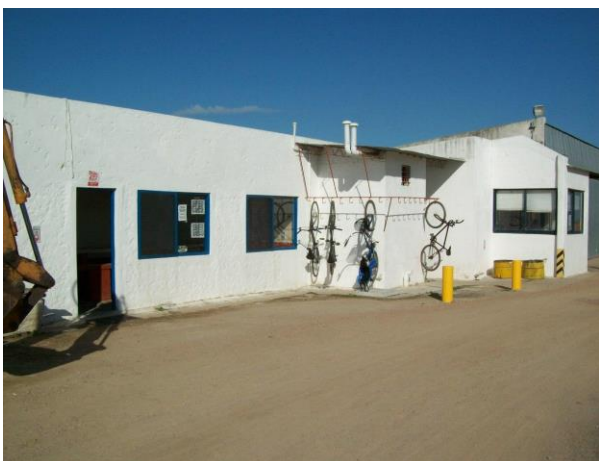
Vista de comedor del personal, baños y depósito
