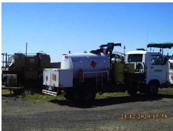
Ilustración 8 – P03, Obrador principal. Camión para traslado de combustible, aceites y lubricantes a frente de obra.
