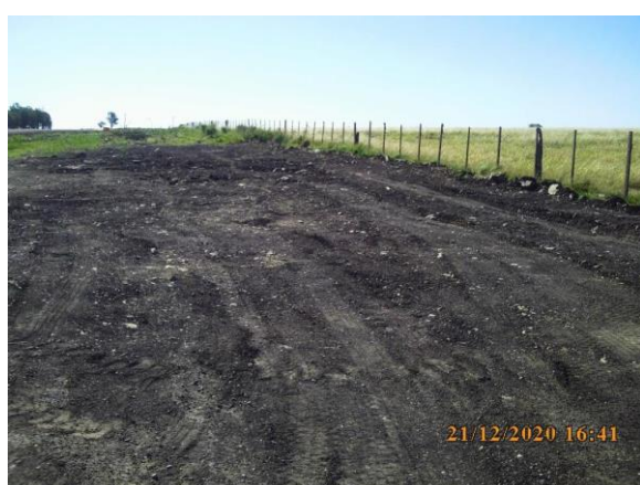
Ilustración 14 – P04, Zona de obrador de Saceem durante obras en alcantarilla en arroyo Cardozo. Terreno restaurado.
