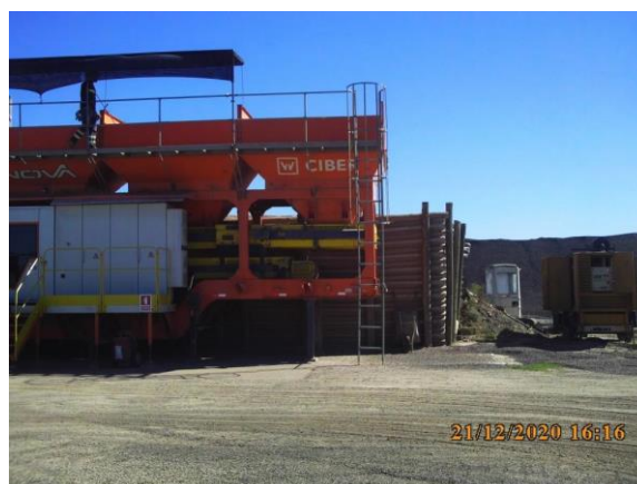
Ilustración 11 – P03, Planta asfáltica.
