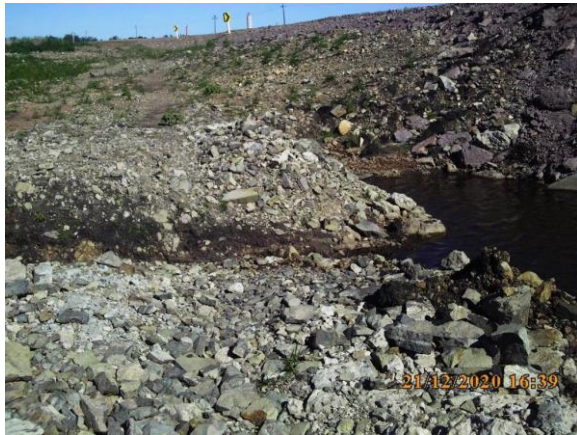
Ilustración 16 – P04, Alcantarilla en arroyo Cardozo. Pase de curso de agua en ataguía.
