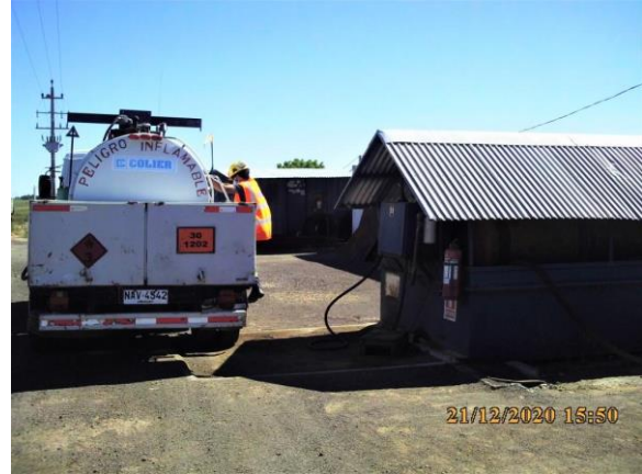
Ilustración 5 – P03, Obrador principal. Vaciado de camión en tanques de reserva de combustible.
