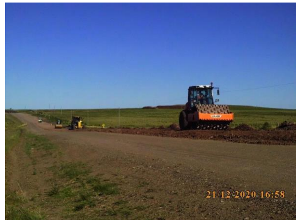
Ilustración 19 – Frente de obra.
