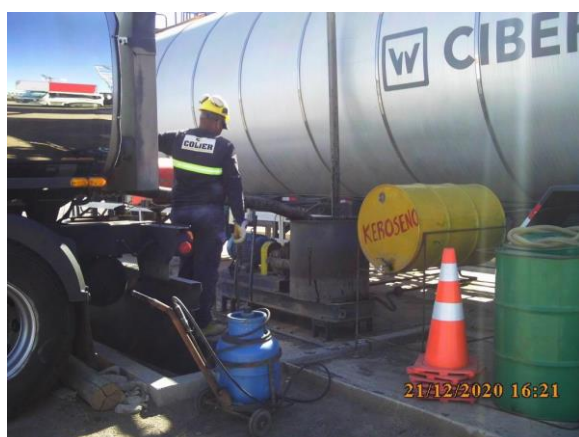
Ilustración 12 – P03, Planta asfáltica.
