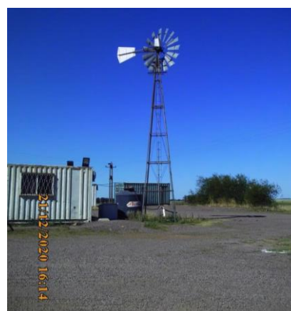
Ilustración 13 – P03, Pozo de extracción de agua.
