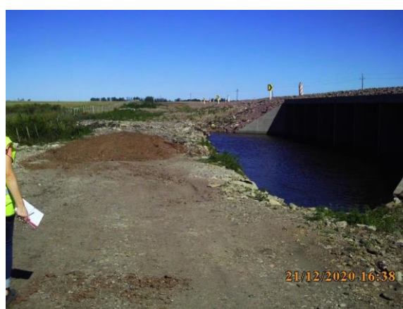
Ilustración 15 – P04, Alcantarilla en arroyo Cardozo. Obras concluidas. Materiales, acopios y escombros de obra retirados. Se mantiene ataguía.
