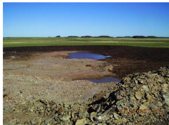
Ilustración 21 – P05, Cantera en Ruta N°43 con tareas de tendido de taludes en proceso.
