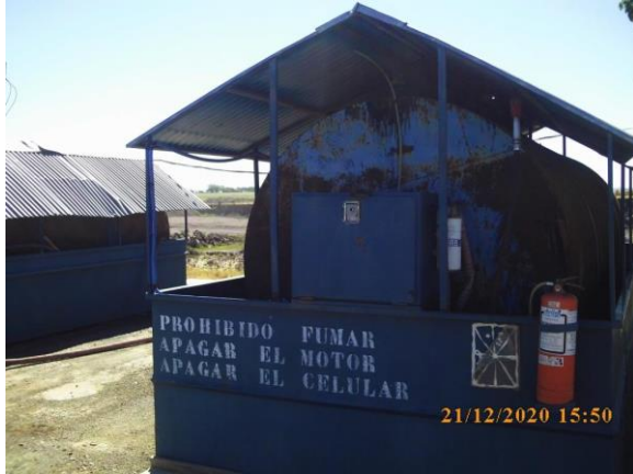
Ilustración 4 – P03, Obrador principal. Tanques de reserva de combustible.
