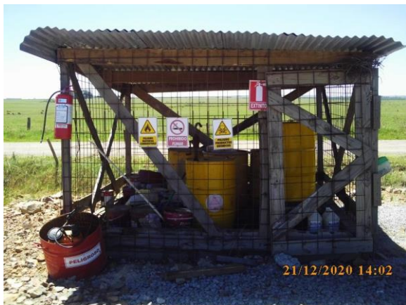
Ilustración 18 – P03, obrador principal. Depósito de productos químicos.
