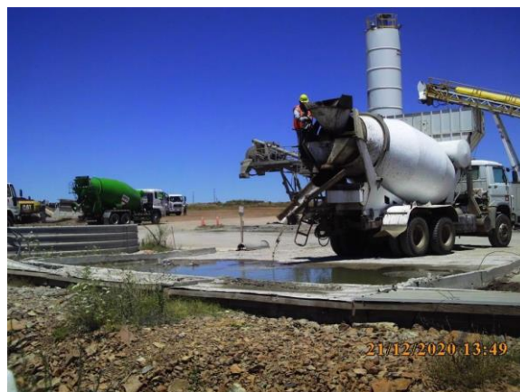
Ilustración 15 – P03, obrador principal. Lavado de camión mixer en pileta.
