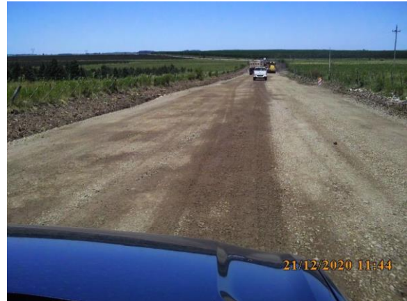
Ilustración 5 – Caminos de obra luego de regado para reducir la presencia de polvo en el aire.
