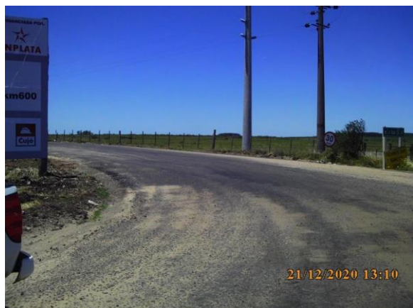
Ilustración 14 – P02, fin de tramo de obra.
