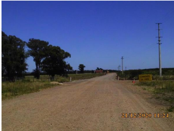
Ilustración 4 – P01, Inicio de tramo de obras.
