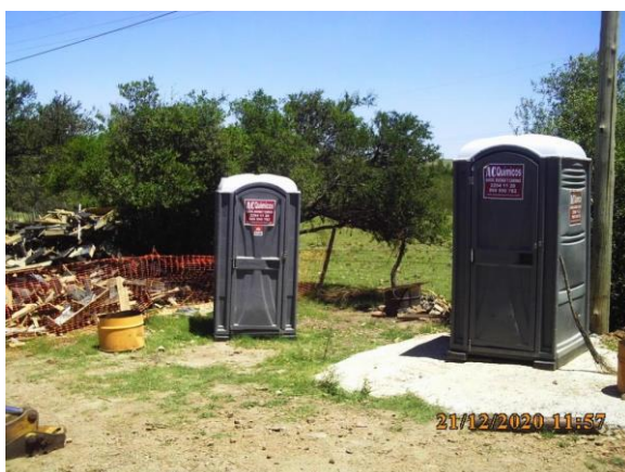
Ilustración 8 – P04, obrador secundario. Baños químicos.
