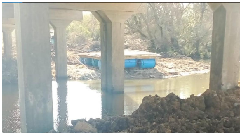
Ilustración 3-1 Balsa de disposición de escombros
