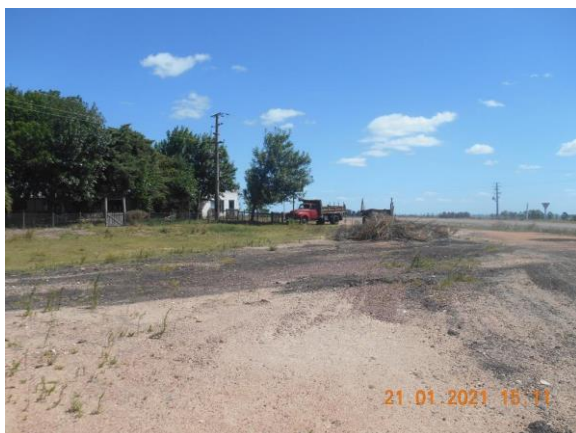
Ilustración 8 – P03, obrador secundario al momento de la visita.
