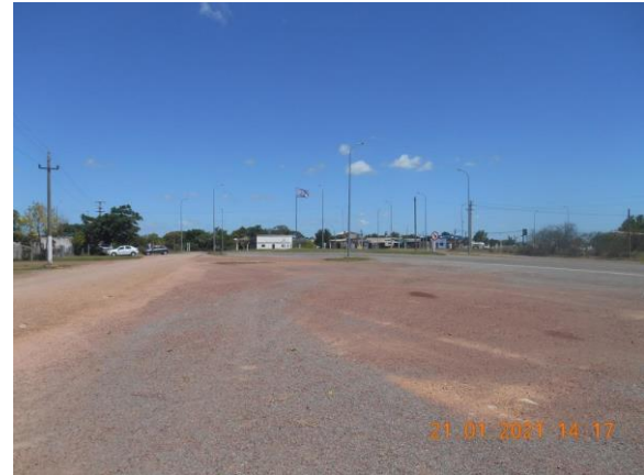
Ilustración 5 – P04, obrador principal desmantelado. Suelos sin descompactar.
