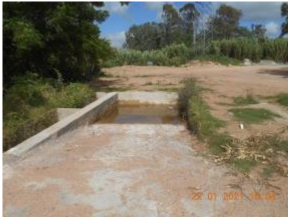
Ilustración 10 – P03, pileta de lavado de hormigones con agua estancada.
