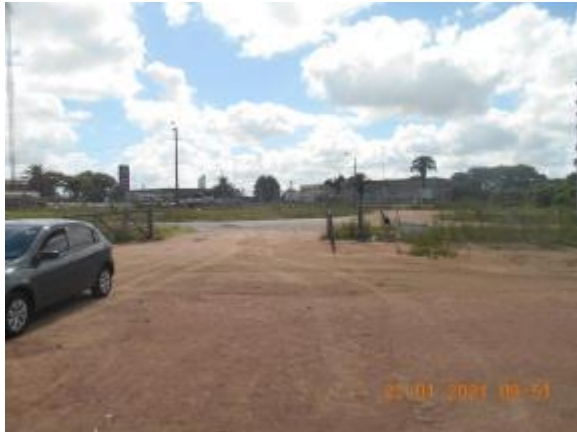
Ilustración 4 – P03, frente de obrador.
