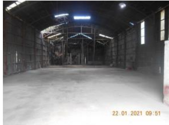
Ilustración 5 – P03, Interior de galpón sin restos de obra.
