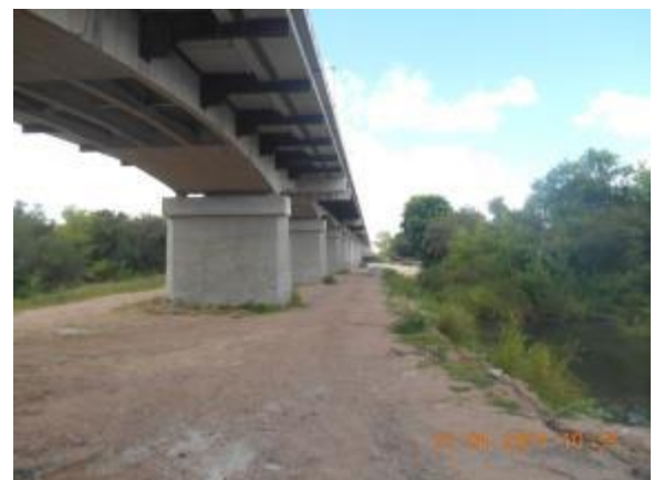
Ilustración 15 – Obras de puente concluidas.
