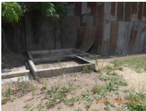
Ilustración 6 – P03, contención en zona de productos químicos.
